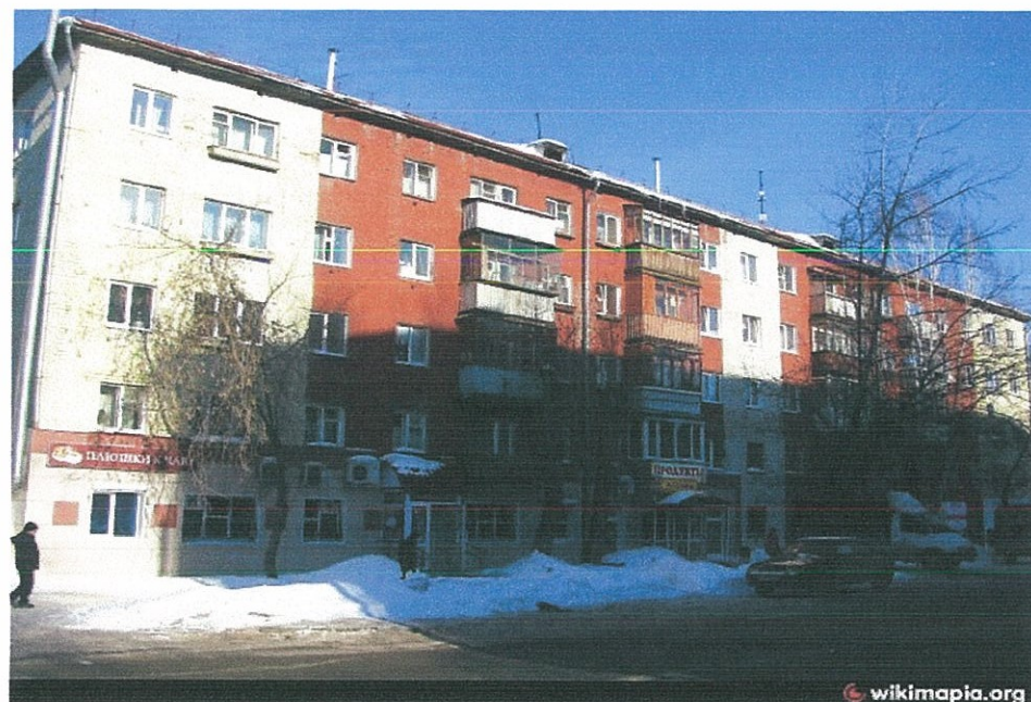
Главный фасад по ул. Академика Веденеева (1)
