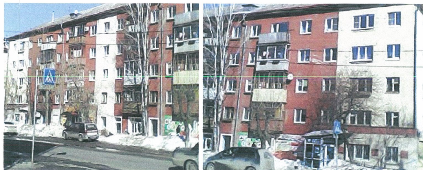
Главный фасад по ул. Академика Веденеева (1)
