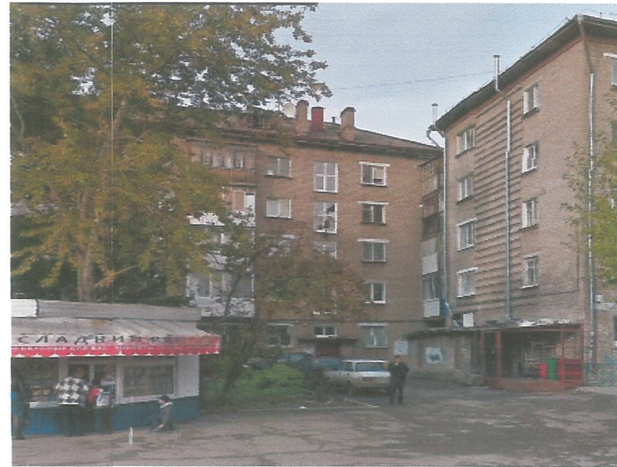
Главный фасад по ул. Генерала Карбышева(2)
