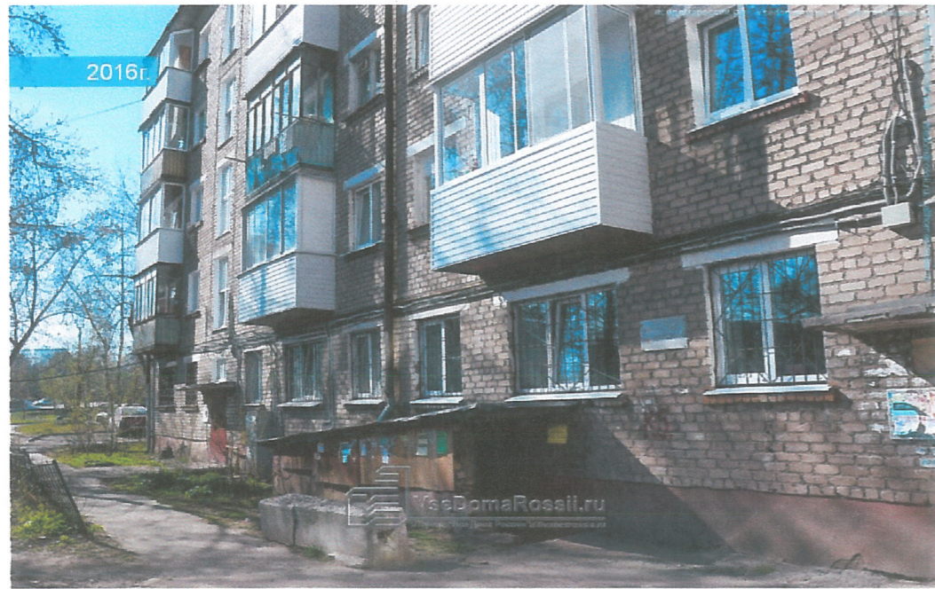
Главный фасад по ул. Генерала Карбышева
