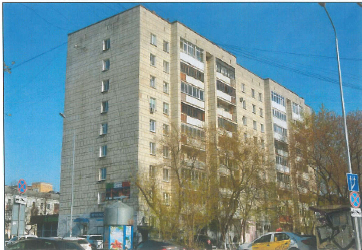
Фасад со стороны Тополевого переулка
