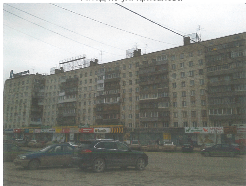
Фасад по ул. Крисанова
