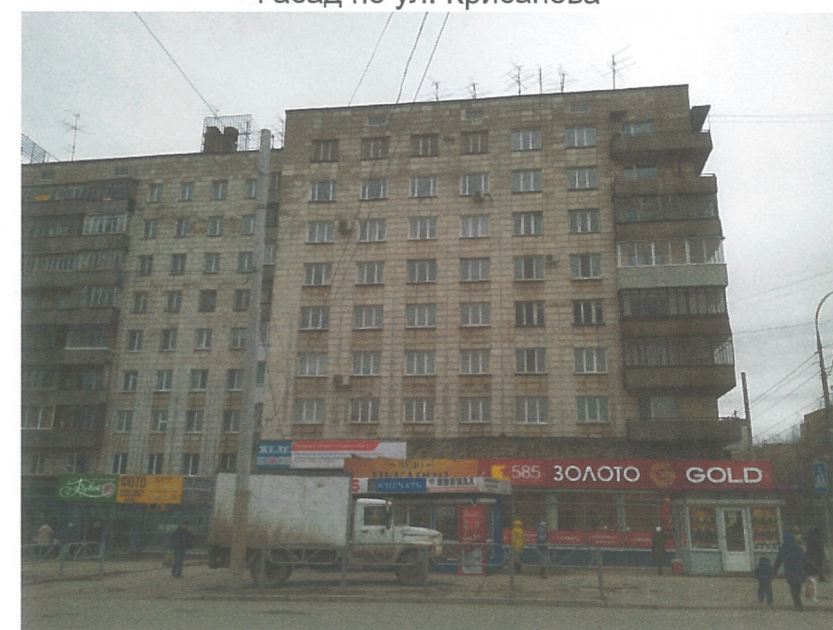
Фасад по ул. Крисанова
