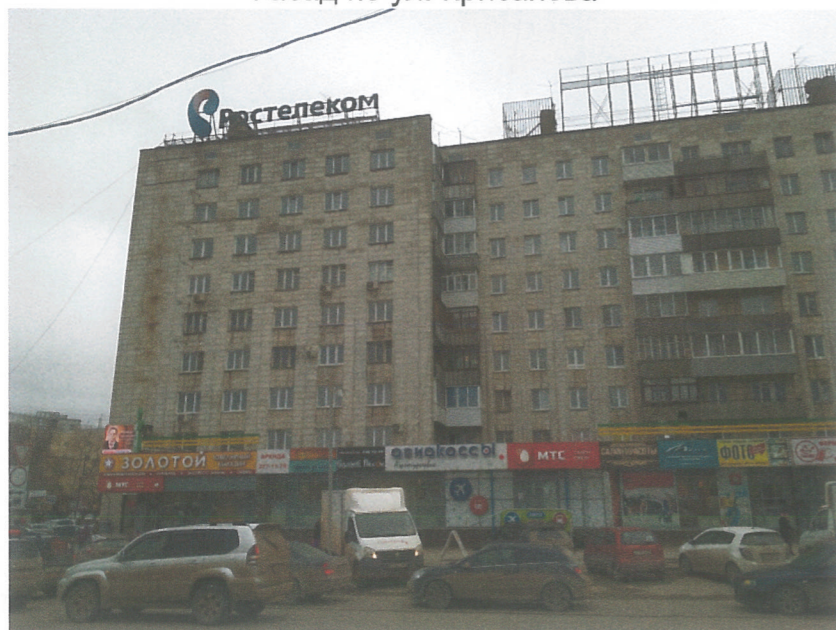
Фасад по ул. Крисанова
