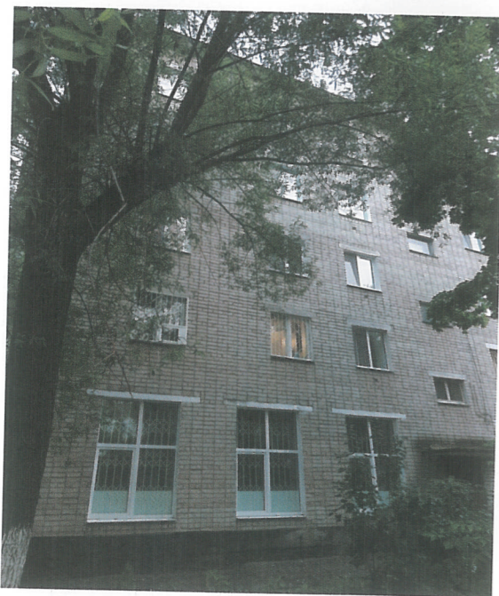
Существующее состояние фасадов (фотофиксация) Дворовой фасад
