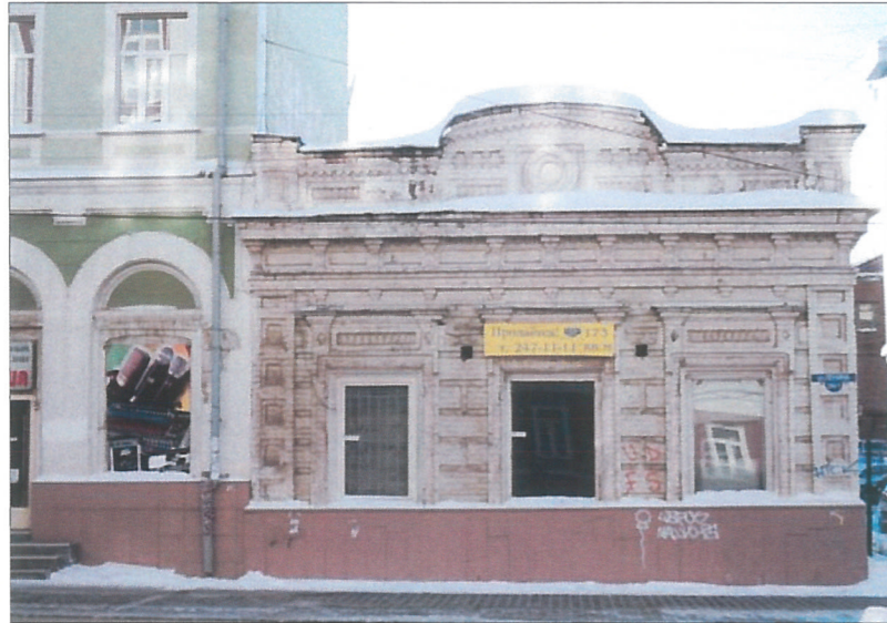
Существующее состояние бокового фасада (фотофиксация)
