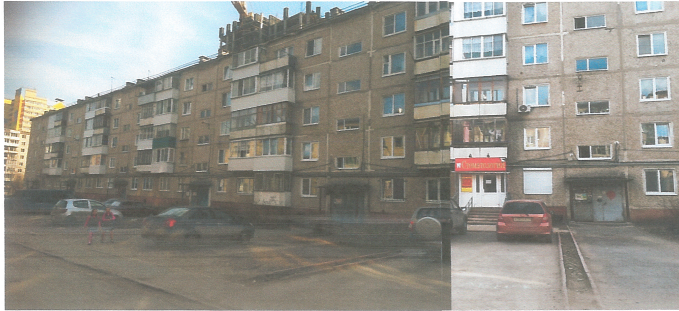
Главный фасад по ул. Маршала Толбухина (межквартирный проезд)
