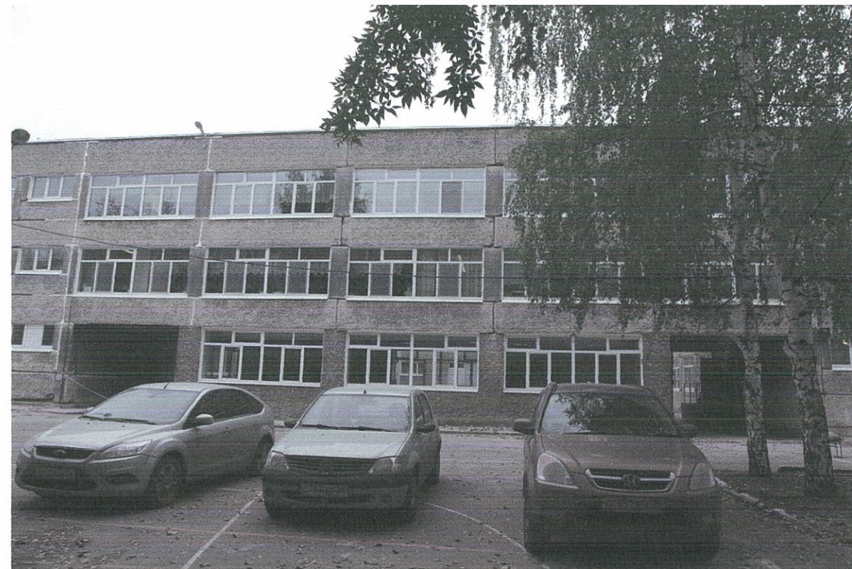
Фасад со стороны ул. Монастырская
