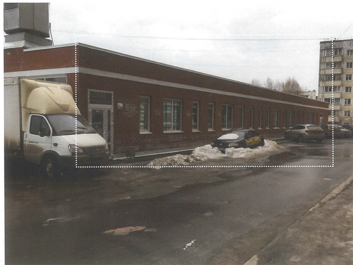
Существующее положение дворового фасада (фотофиксация)
