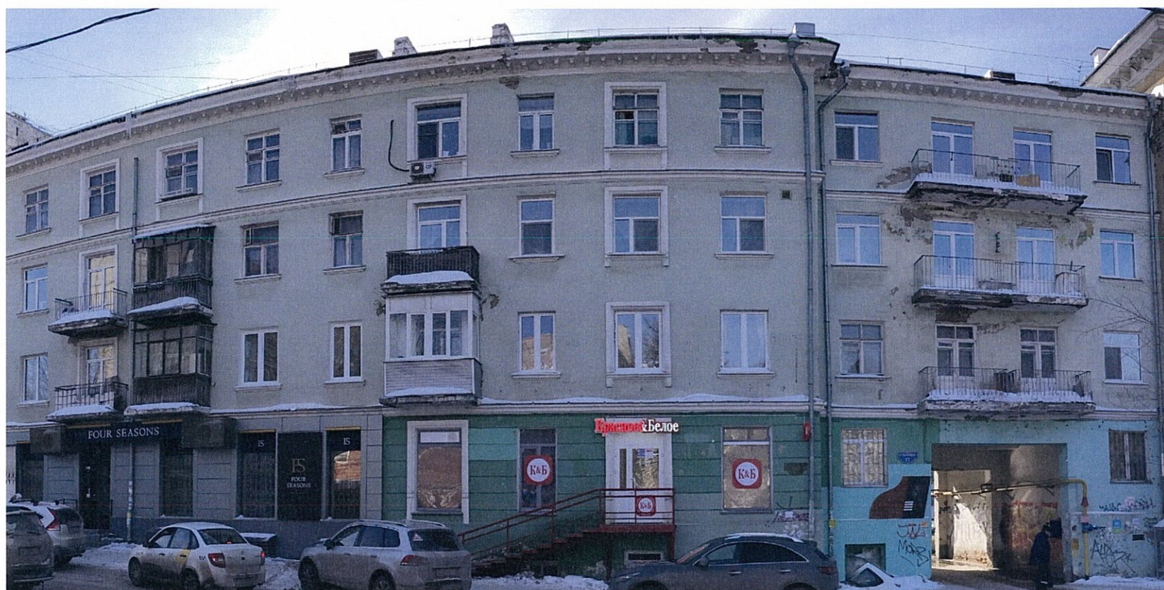
Существующее состояние главного фасада (фотофиксация).
