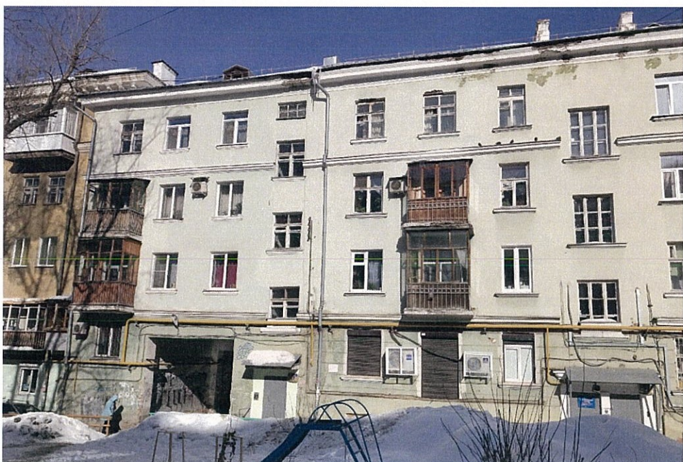
Существующее состояние дворового фасада (фотофиксация).
