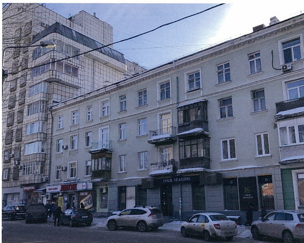
Существующее состояние главного фасада (фотофиксация).
