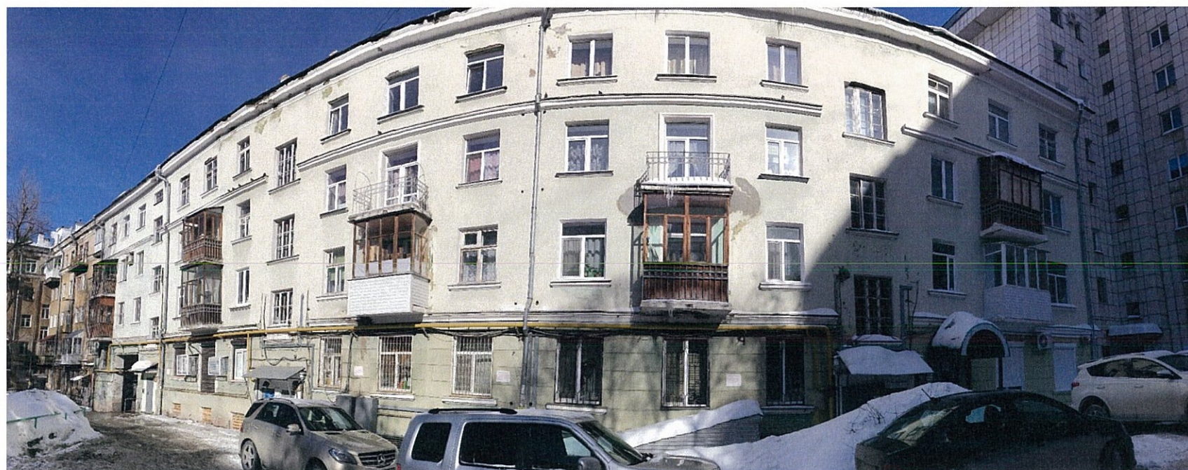
Существующее состояние дворового фасада (фотофиксация).
