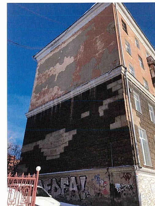
Существующее состояние бокового фасада (фотофиксация).
