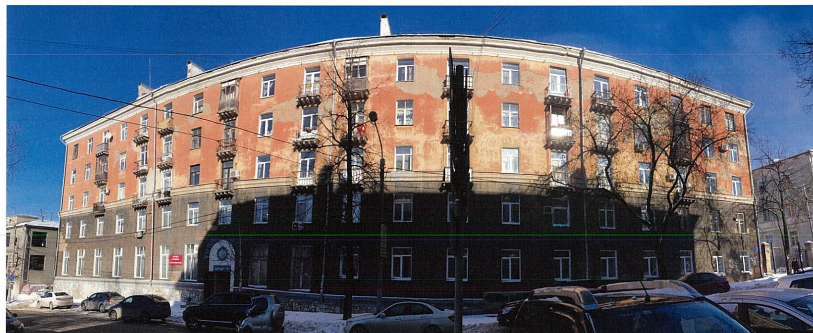
Существующее состояние главного фасада (фотофиксация).
