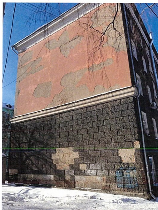
Существующее состояние бокового фасада (фотофиксация).
