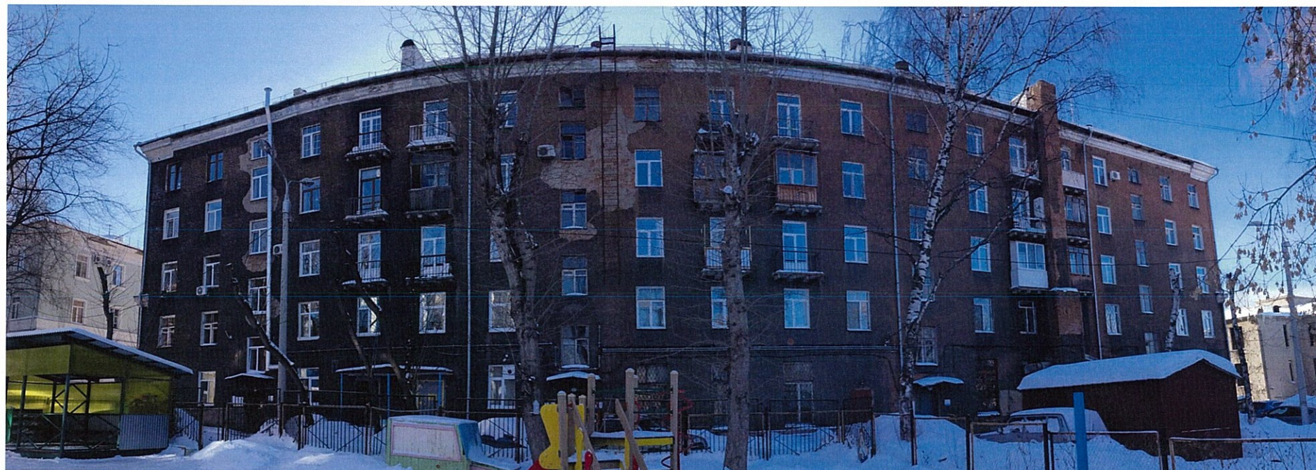
Существующее состояние дворового фасада (фотофиксация).
