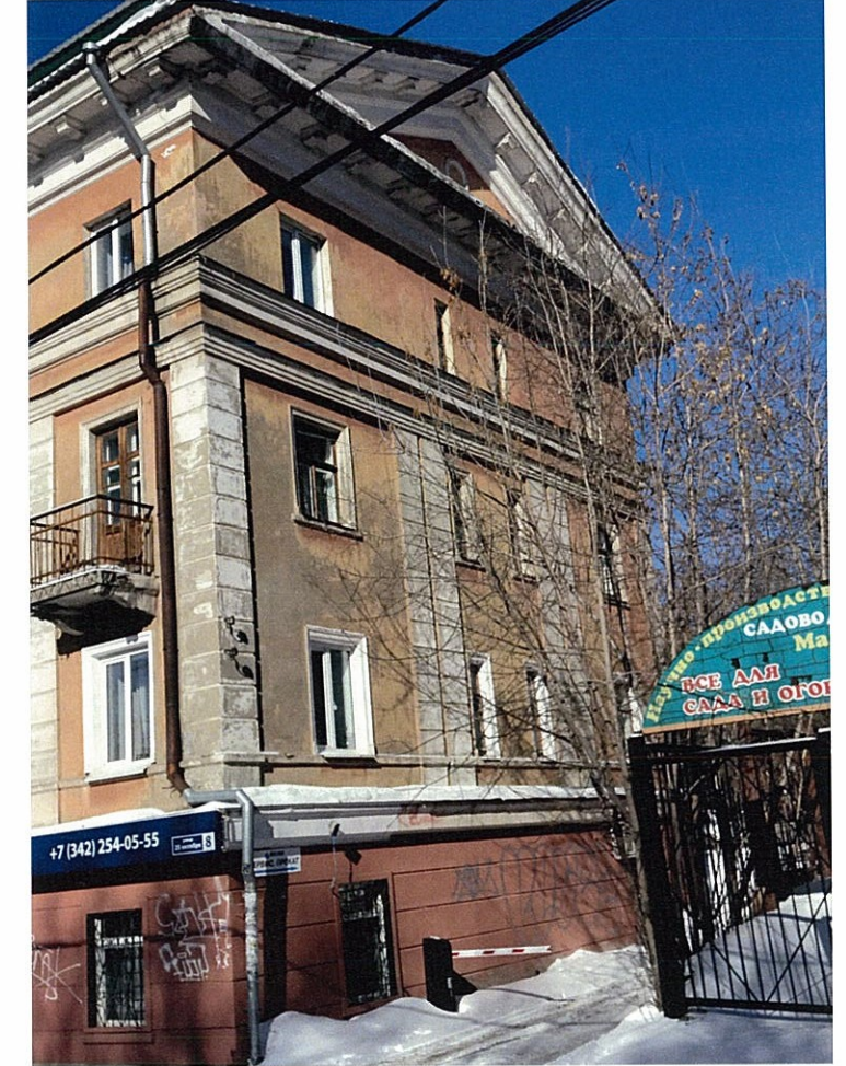
Существующее состояние бокового фасада (фотофиксация).
