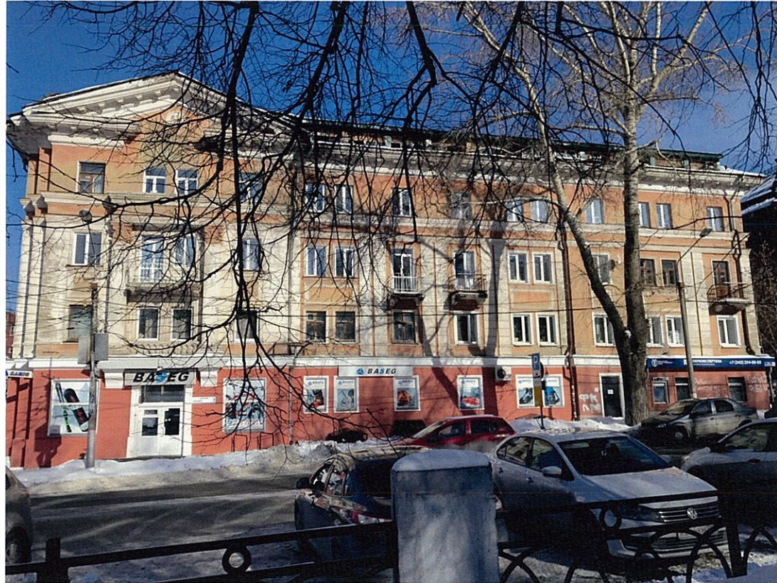
Существующее состояние главного фасада (фотофиксация).
