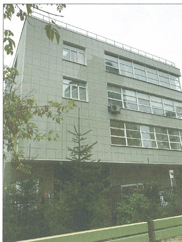
Торцевой фасад (левый)
