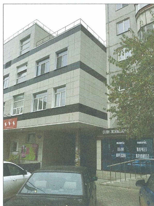
Торцевой фасад (правый)
