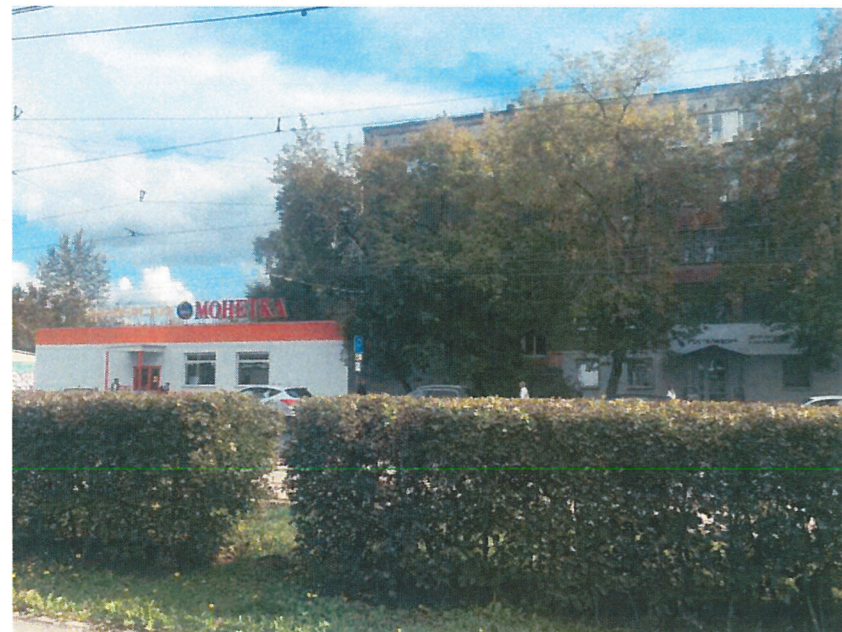
Существующее состояние фасадов (фотофиксация)
