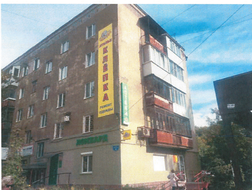
Существующее состояние фасадов (фотофиксация)
