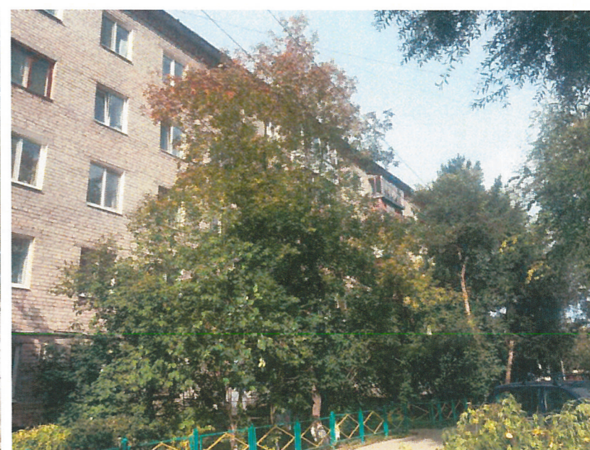
Существующее состояние фасадов (фотофиксация)
