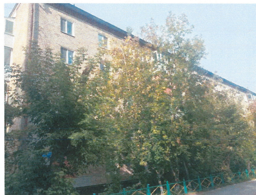
Существующее состояние фасадов (фотофиксация)
