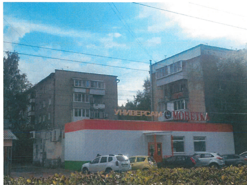
Существующее состояние фасадов (фотофиксация)
