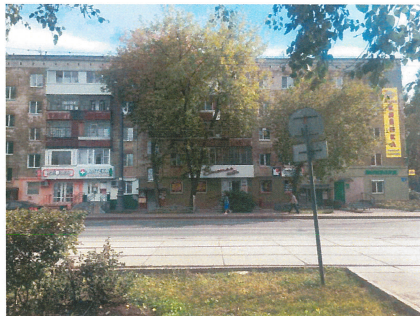
Существующее состояние фасадов (фотофиксация)
