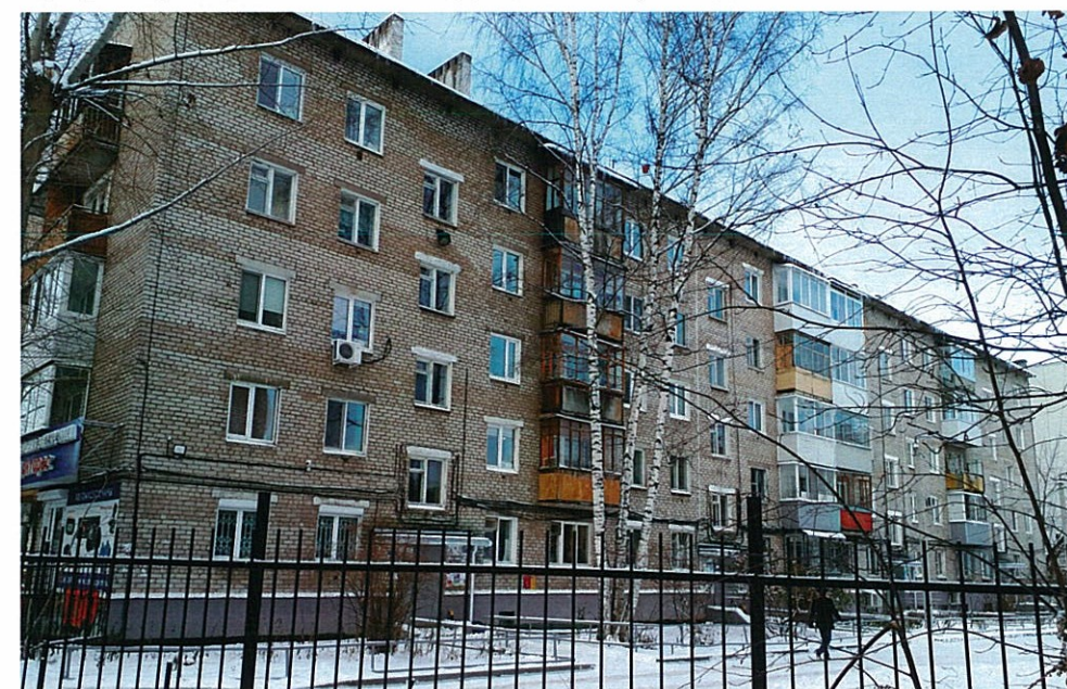
Существующее состояние дворового фасада
