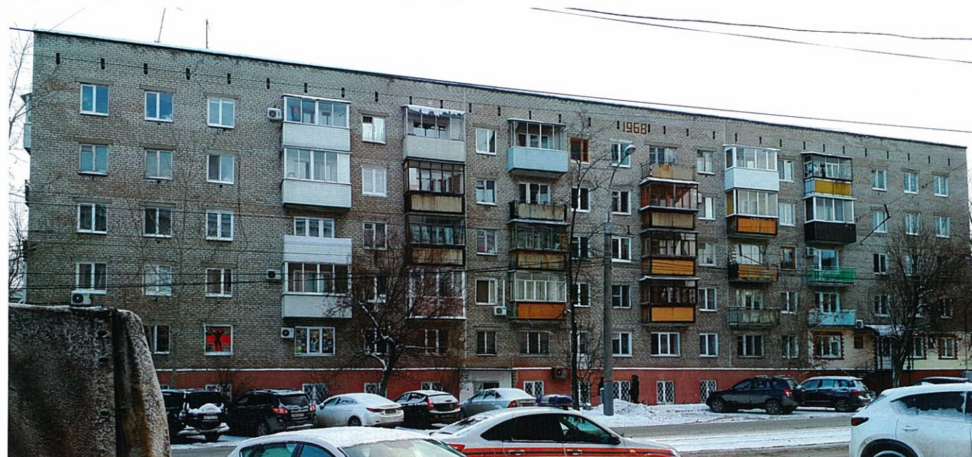
Существующее состояние главного фасада
