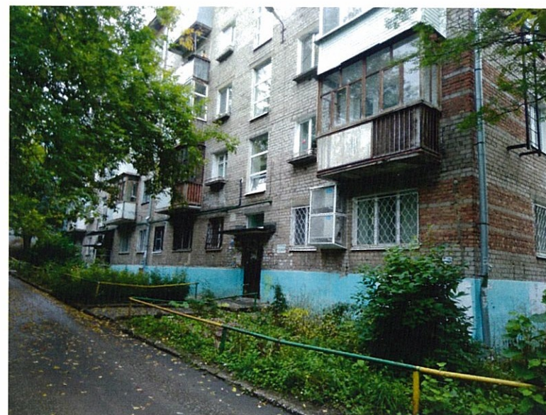
Существующее состояние дворового фасада
