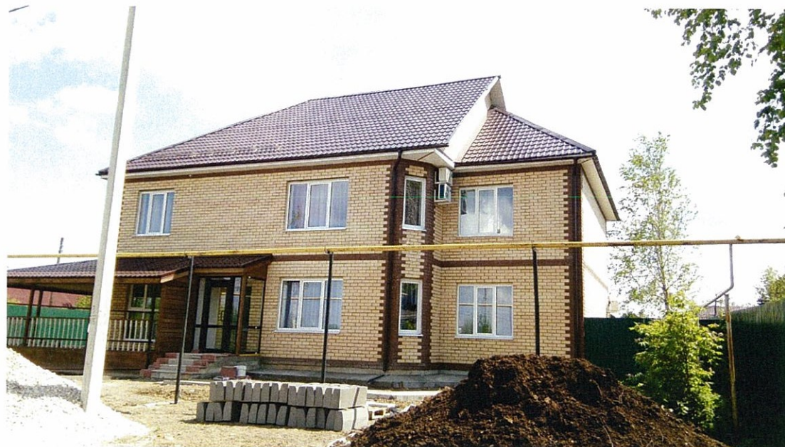
Существующее состояние главного фасада
