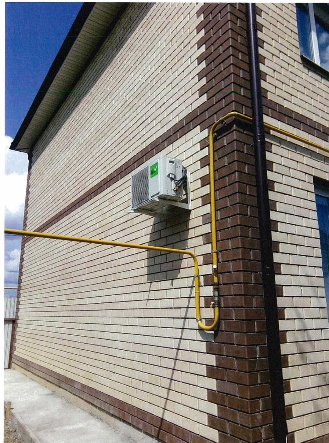
Существующее бокового фасада
