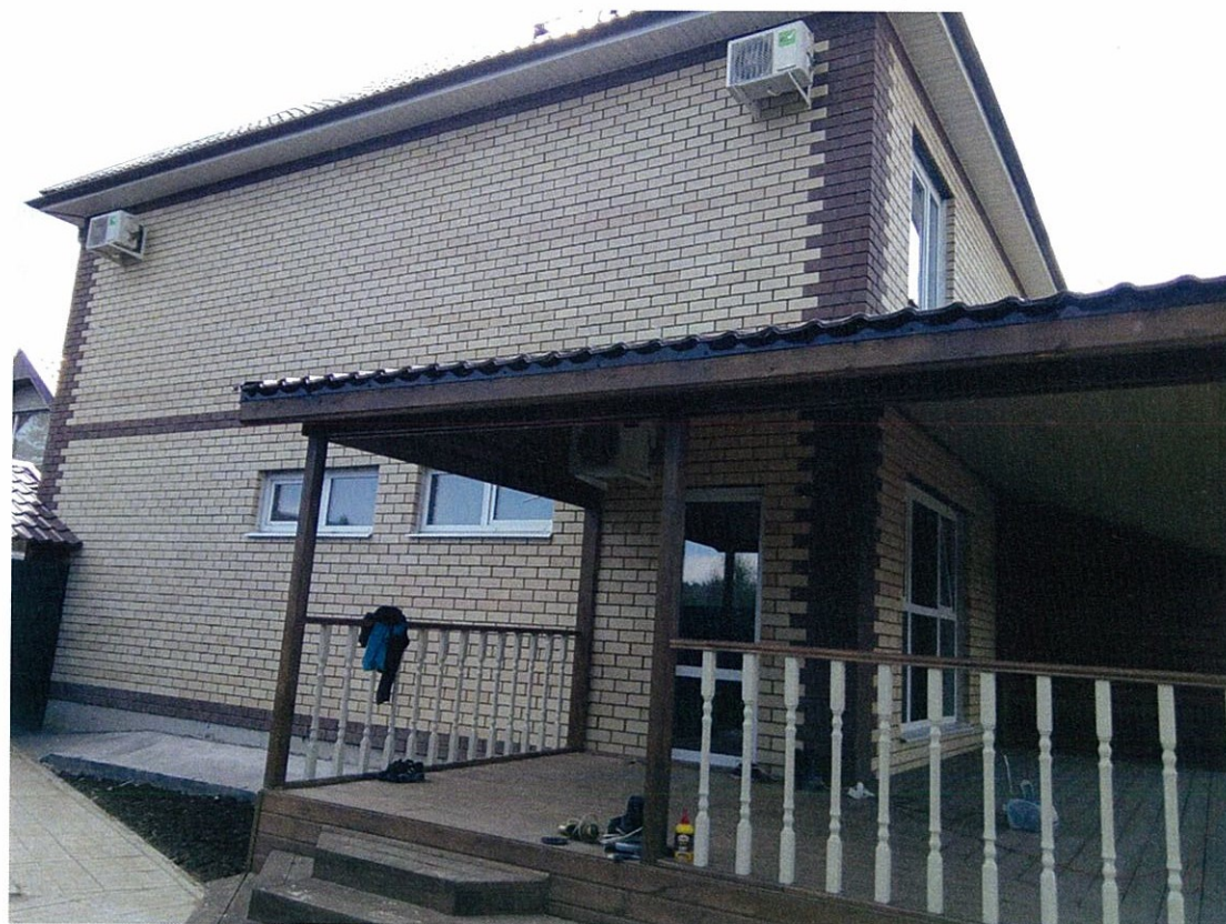
Существующее бокового фасада
