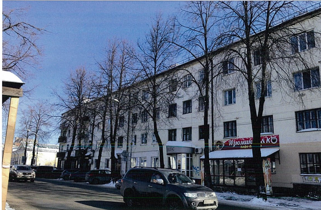
Существующее состояние главного фасада (фотофиксация).
