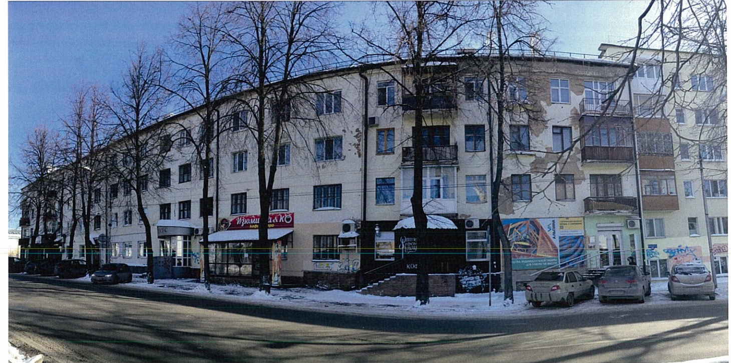
Существующее состояние главного фасада (фотофиксация).
