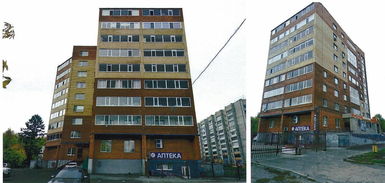
Существующее состояние бокового фасада (фотофиксация).
