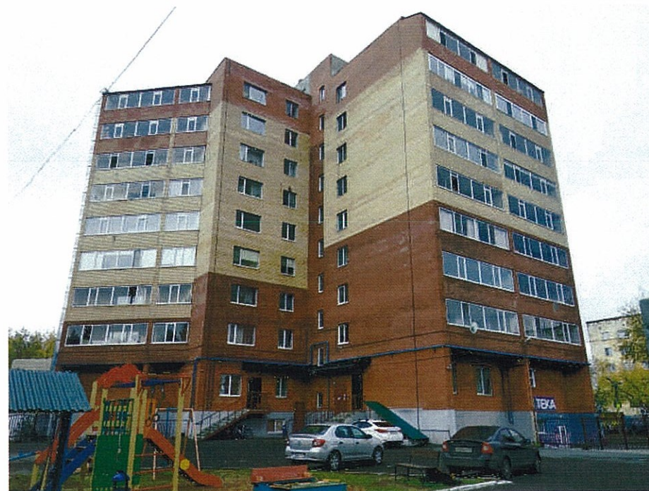
Существующее состояние дворового фасада (фотофиксация).
