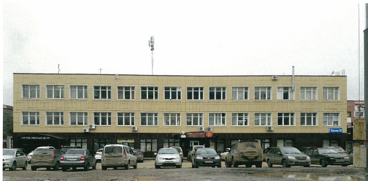
Существующее состояние главного фасада (фотофиксация).
