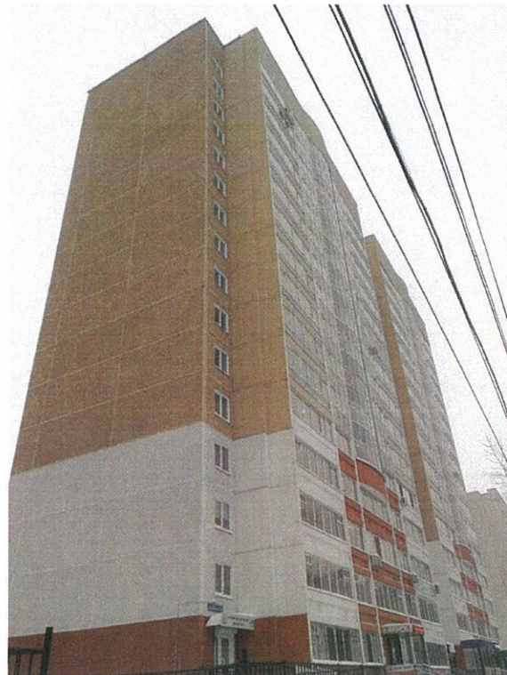
Фасад со стороны ул. Адмирала Ушакова
