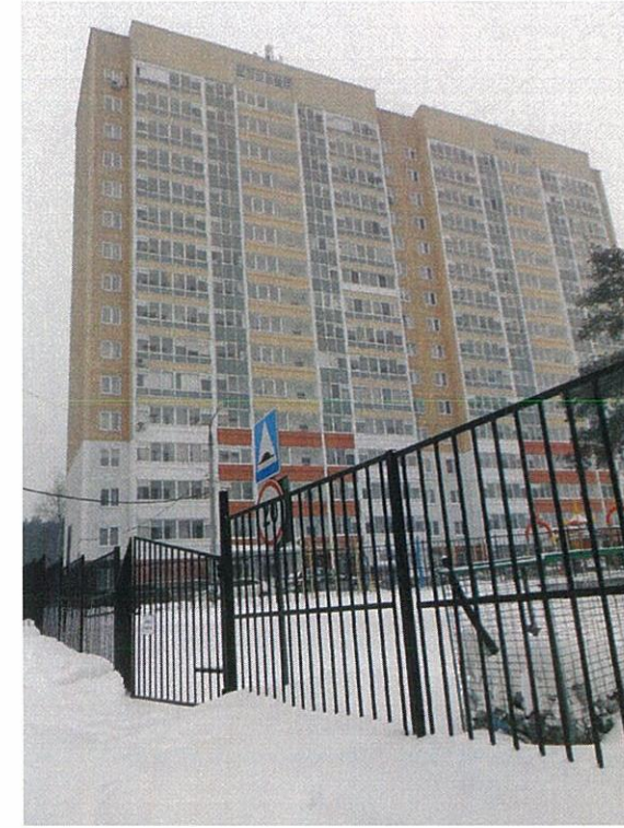
Фасад со стороны двора
