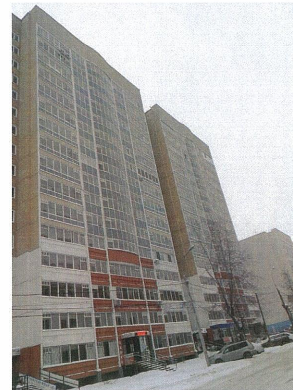
Фасад со стороны ул. Калинина
