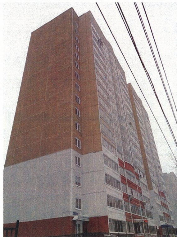
Фасад со стороны ул. Адмирала Ушакова
