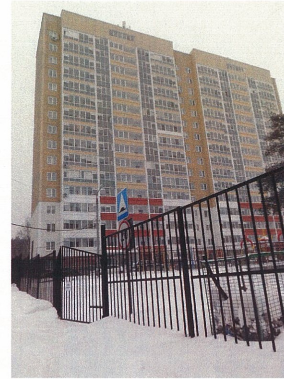
Фасад со стороны двора
