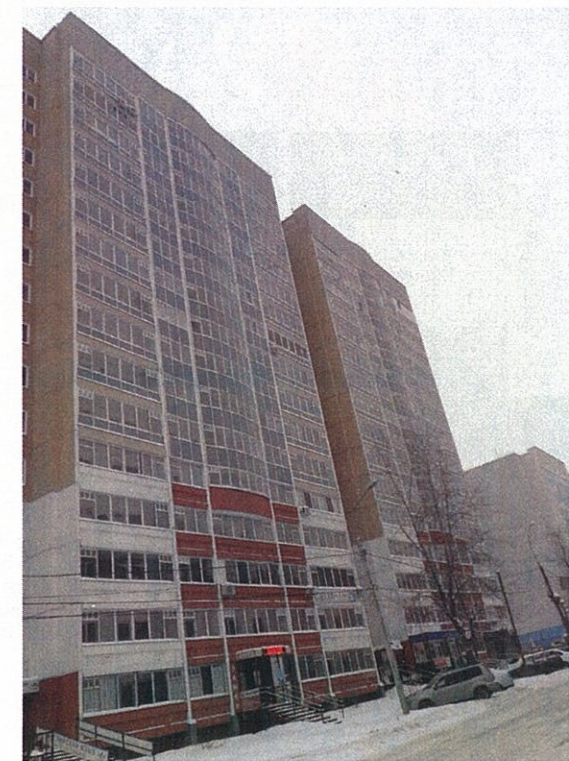
Фасад со стороны ул. Калинина
