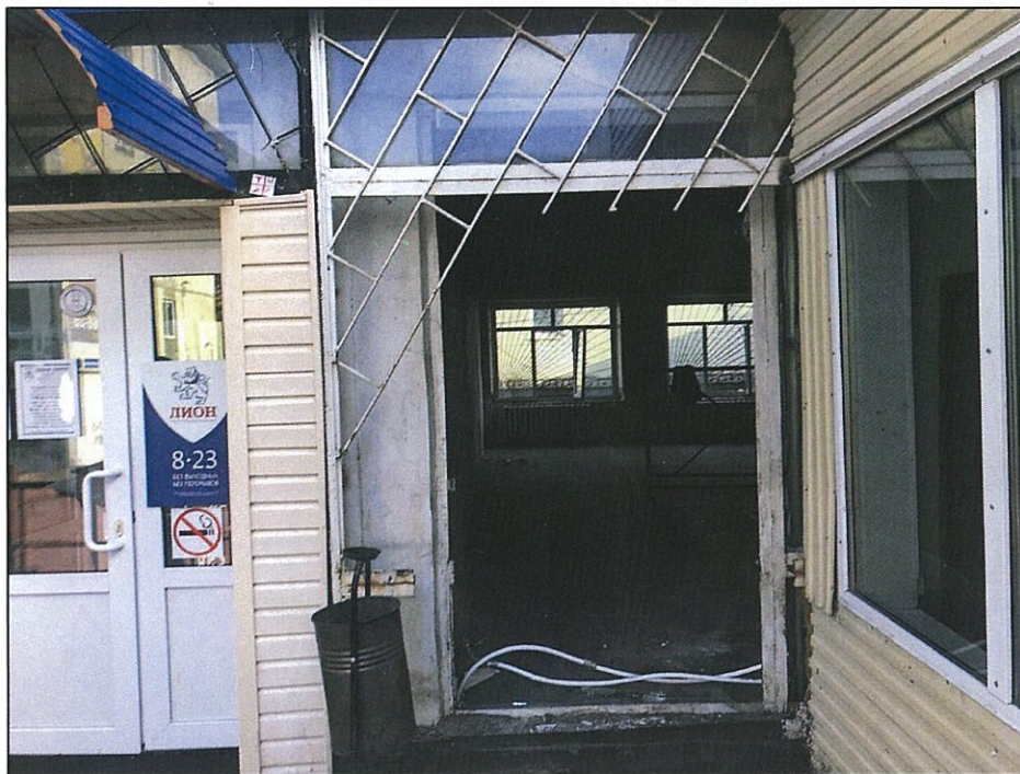
Дверь эвакуационного выхода из торгового зала
