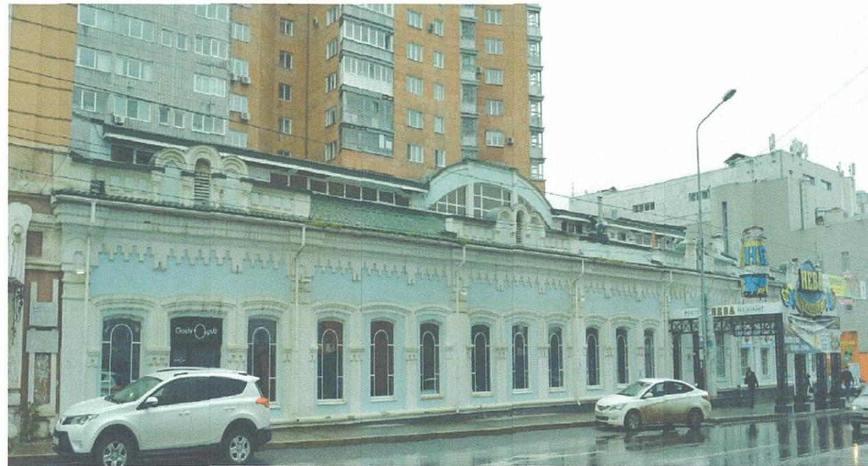
Главный фасад по ул.Куйбышева (существующее состояние)
