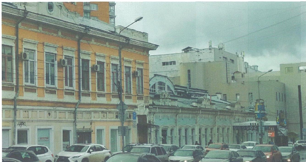
Главный фасад по ул.Куйбышева (существующее состояние)
