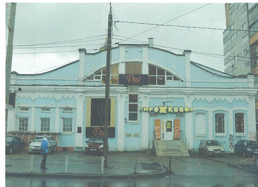
Боковой фасад по ул.Пермская (существующее состояние)
