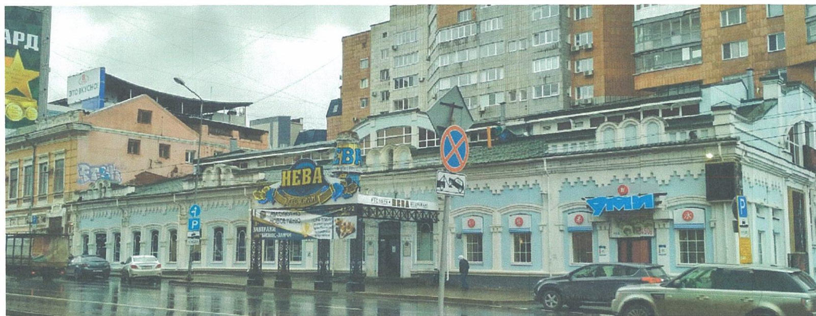
Главный фасад по ул.Куйбышева (существующее состояние)
