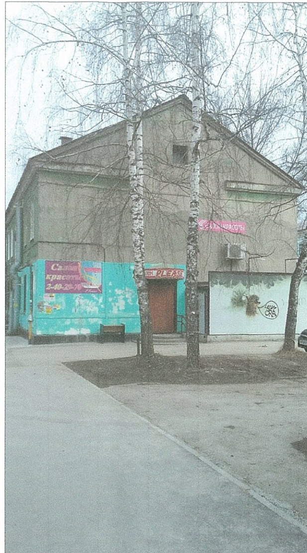
Существующее состояние бокового фасада (фотофиксация)
