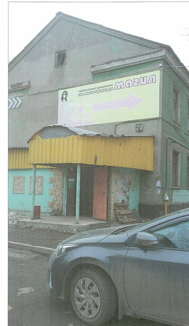
Существующее состояние бокового фасада (фотофиксация)
