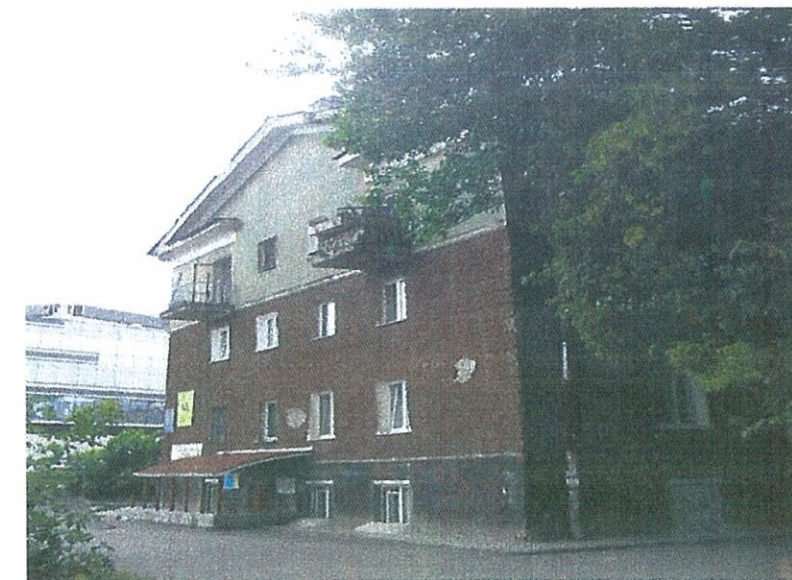
Боковой фасад (западный)
