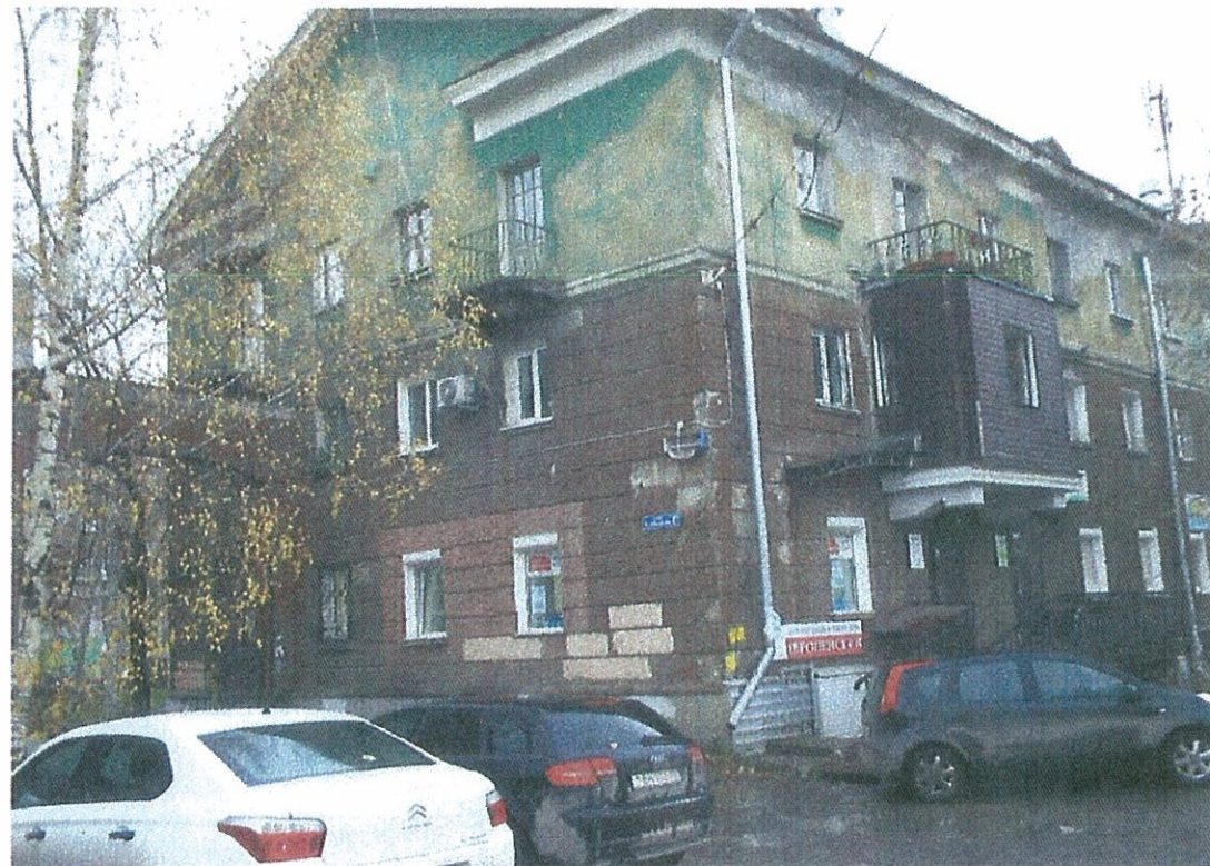
Фасад на ул.Куйбышева
