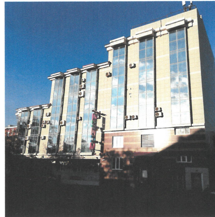
Существующее состояние бокового фасада (фотофиксация).
