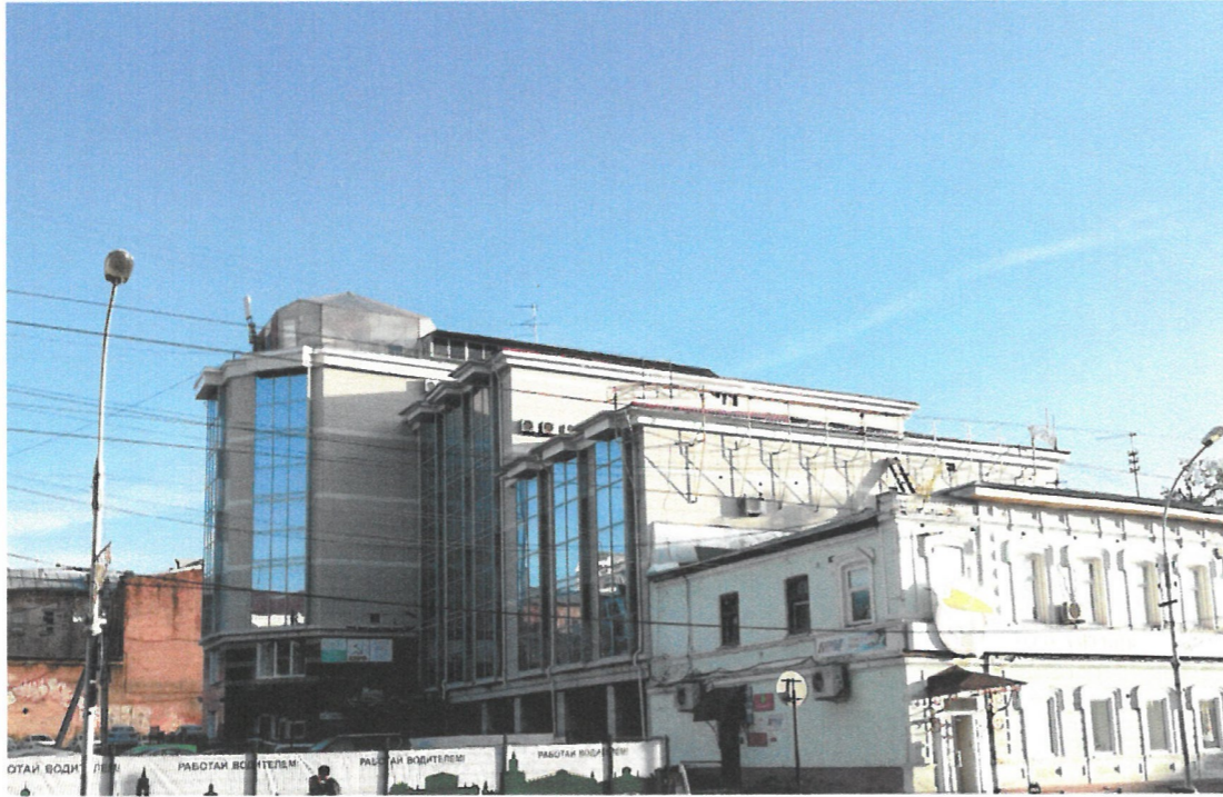
Существующее состояние главного фасада (фотофиксация).
