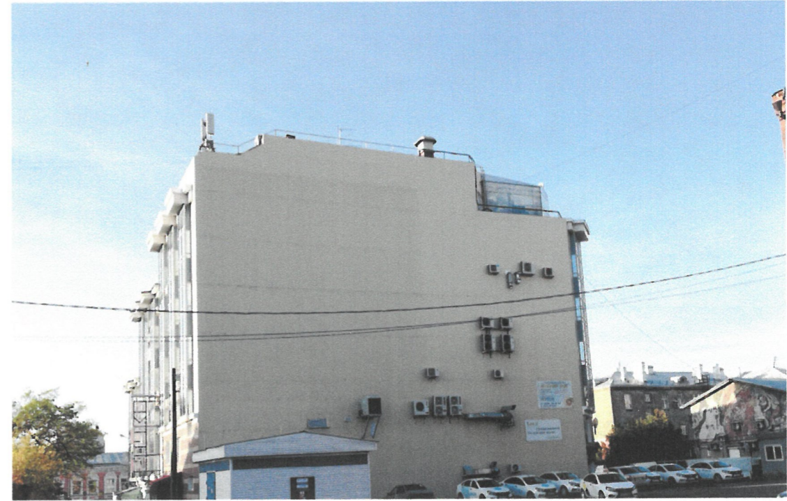
Существующее состояние дворового фасада (фотофиксация).
