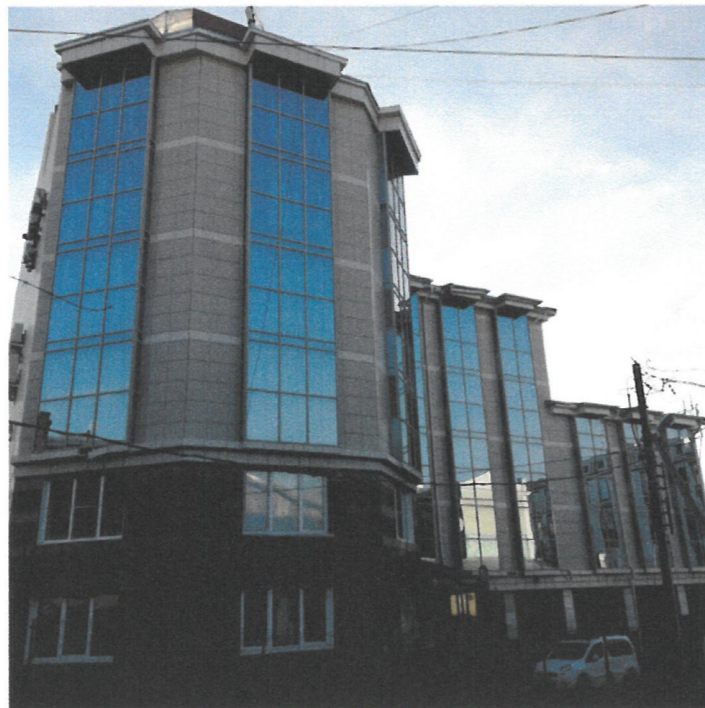
Существующее состояние главного фасада (фотофиксация).
