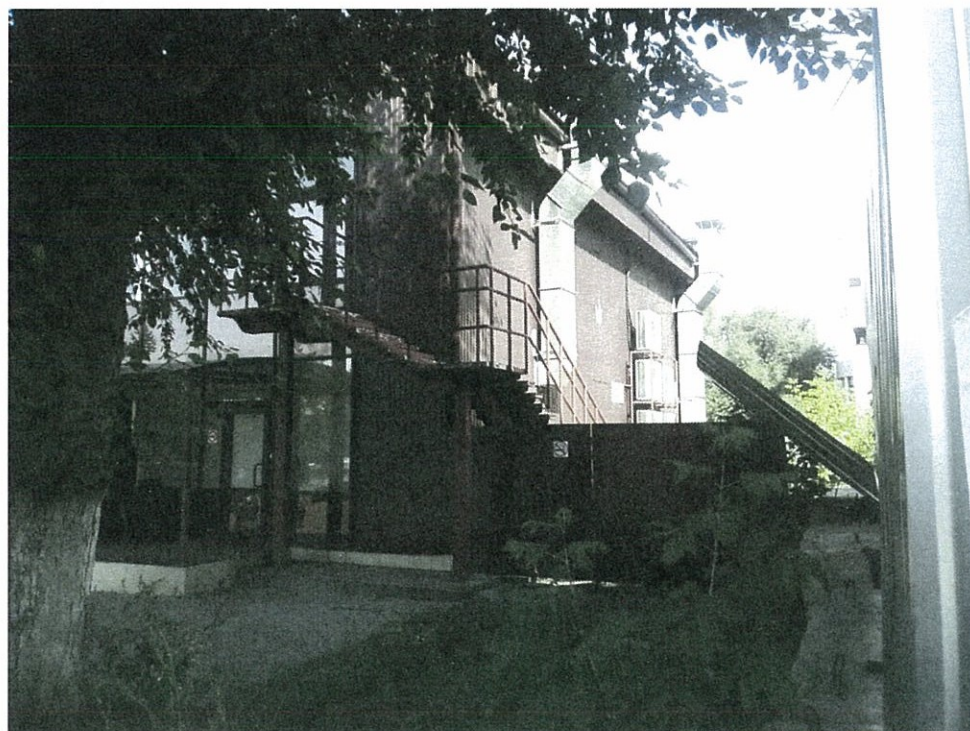
Дворовой фасад (существующее положение)
