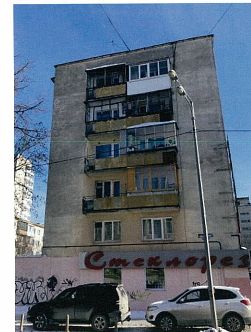
Существующее состояние бокового фасада (фотофиксация).
