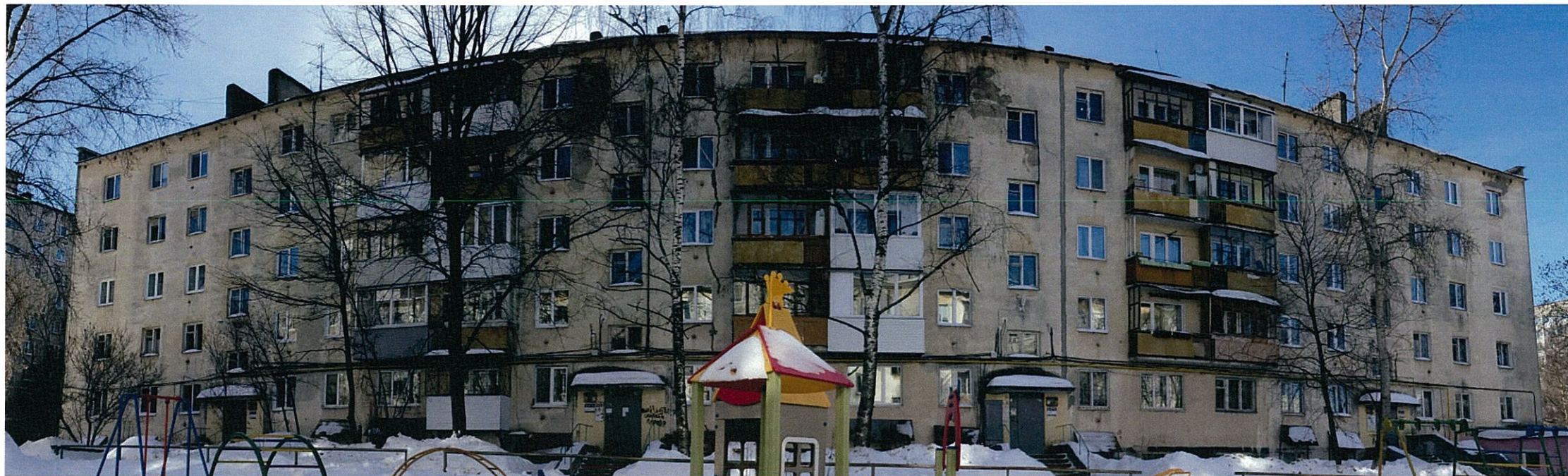
Существующее состояние дворового фасада (фотофиксация).
