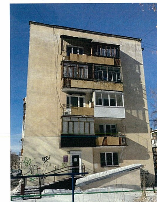
Существующее состояние бокового фасада (фотофиксация).
