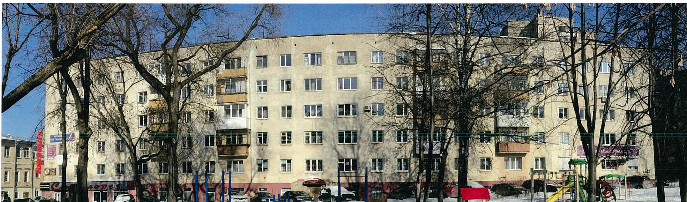
Существующее состояние главного фасада (фотофиксация).
