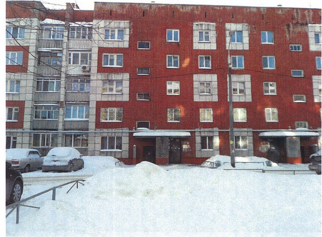
Фасад со стороны ул. Машинистов (в осях Б-В)
