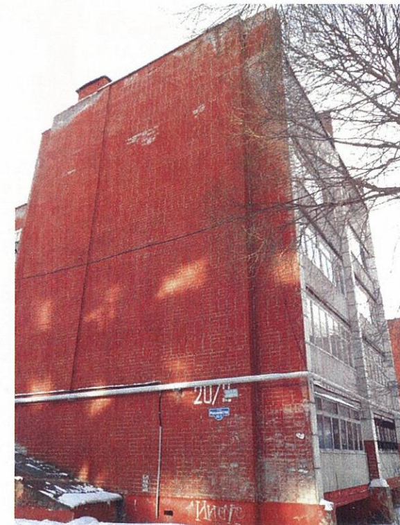
Фасад со стороны ул. Машинистов (в осях В-Г)
