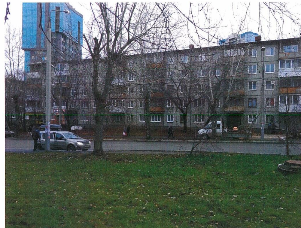
Фасад со стороны ул.Мильчакова
