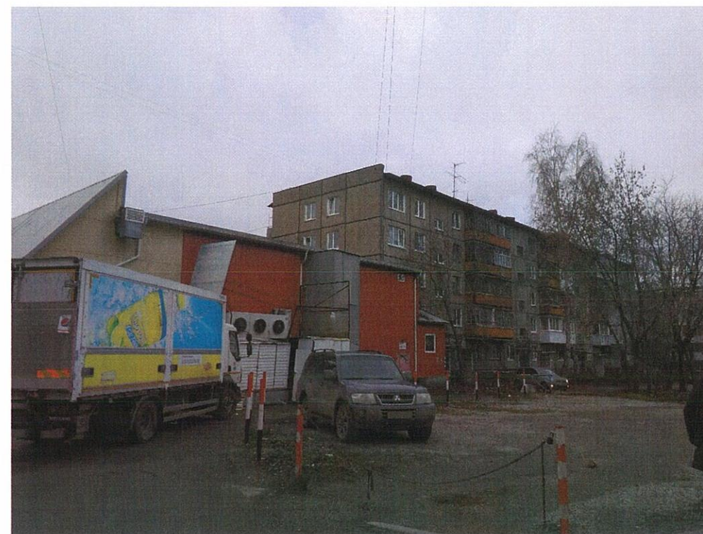
Фасад со стороны ул.Связистов
