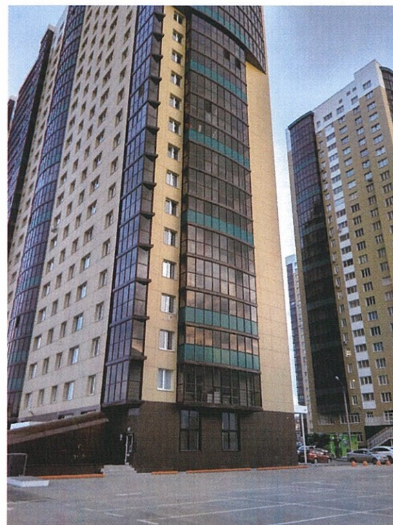
Фасад со стороны ул. 1-я Красноармейская
