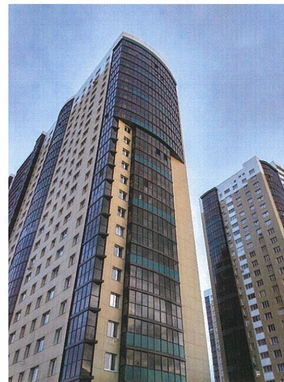
Фасад со стороны ул. 1-я Красноармейская
