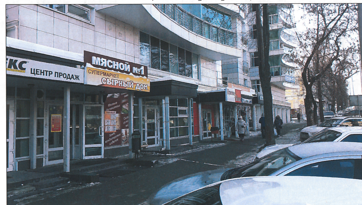
Боковой фасад по ул. Луначарского
