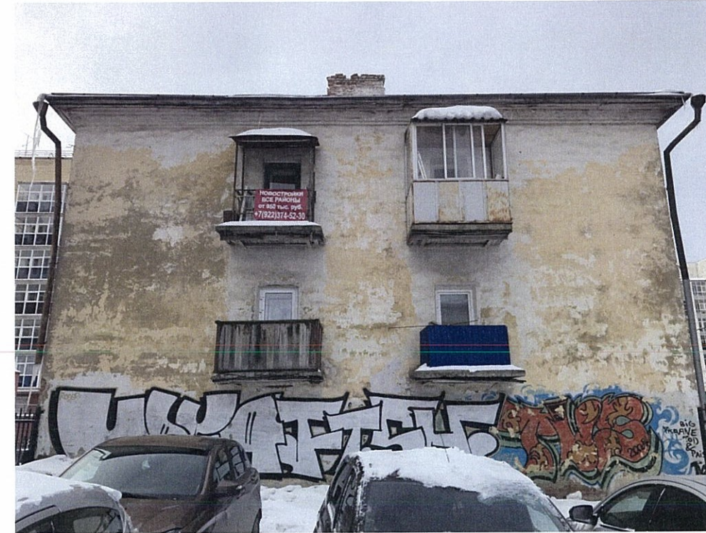
Существующее боковых фасадов (фотофиксация).
