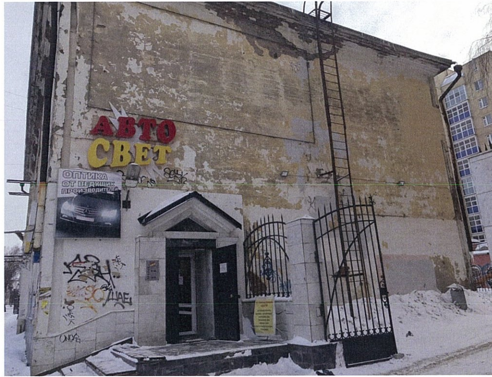
Существующее боковых фасадов (фотофиксация).
