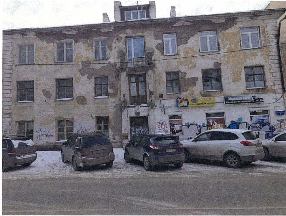
Существующее состояние главного фасада (фотофиксация).
