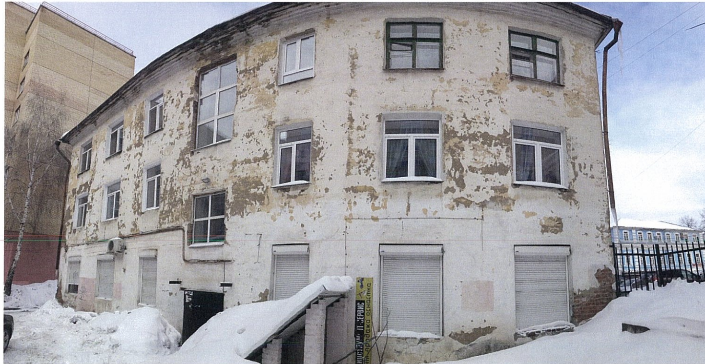
Существующее состояние дворового фасада (фотофиксация).
