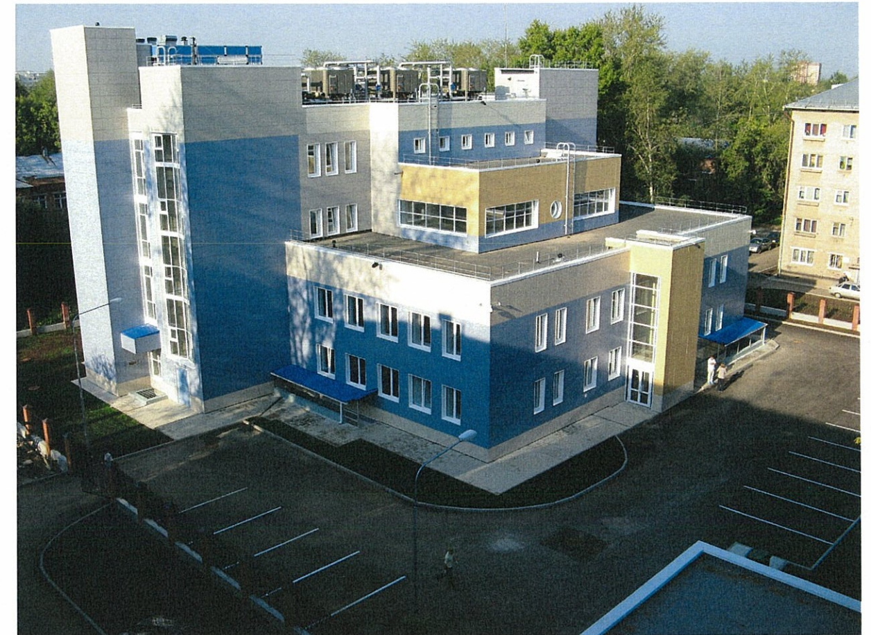
Существующее состояние фасадов (фотофиксация)
