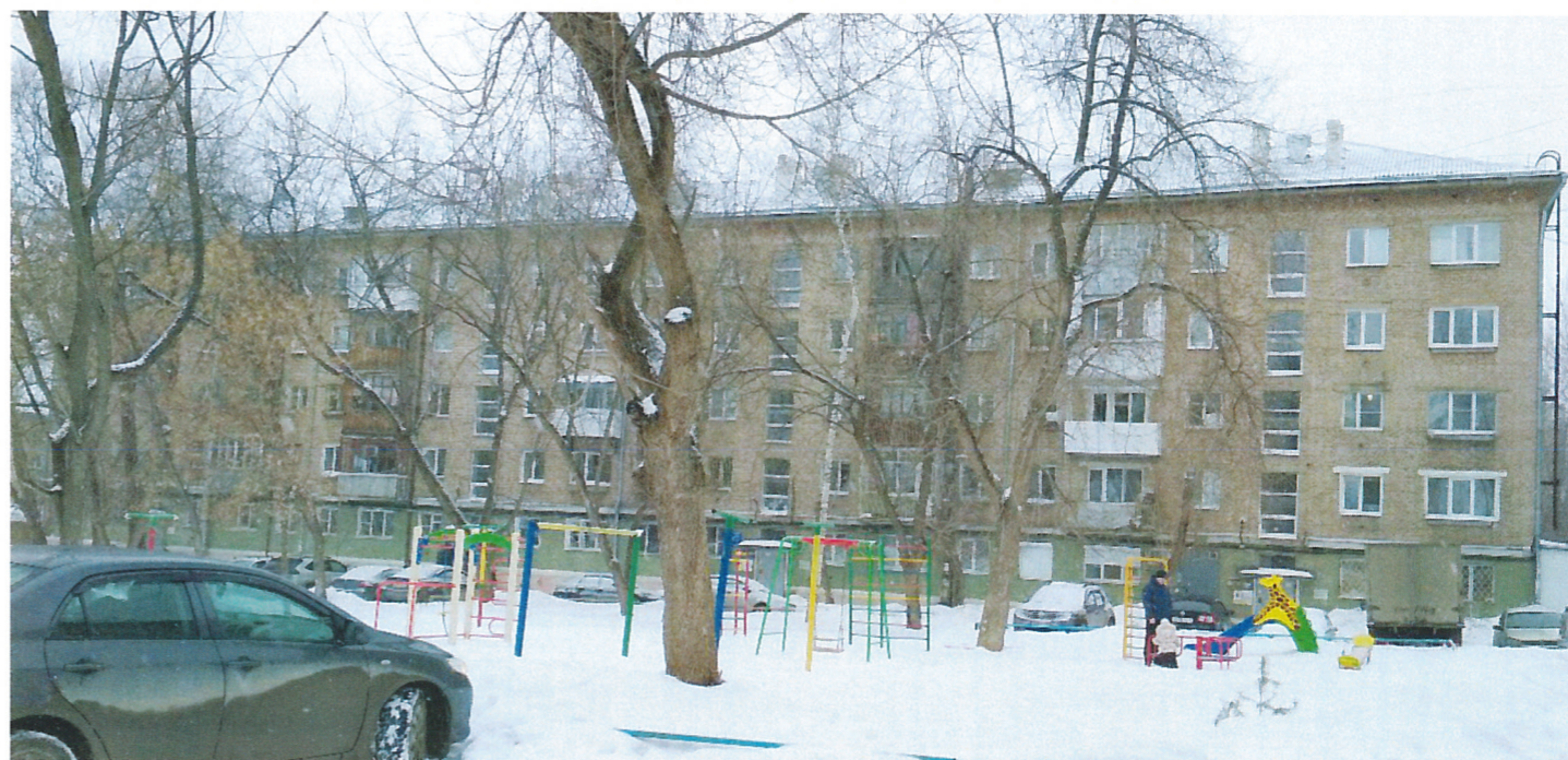
Дворовый фасад (существующее положение)
