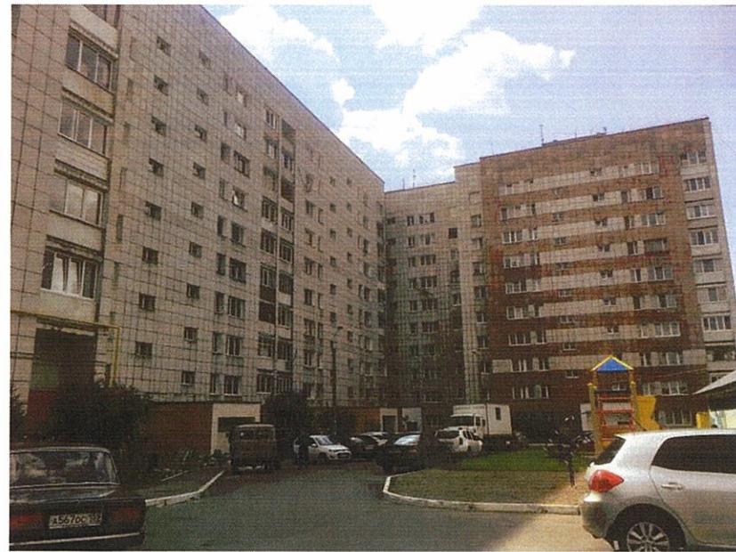
Существующее состояние фасадов (фотофиксация)
