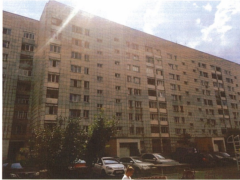
Существующее состояние фасадов (фотофиксация)
