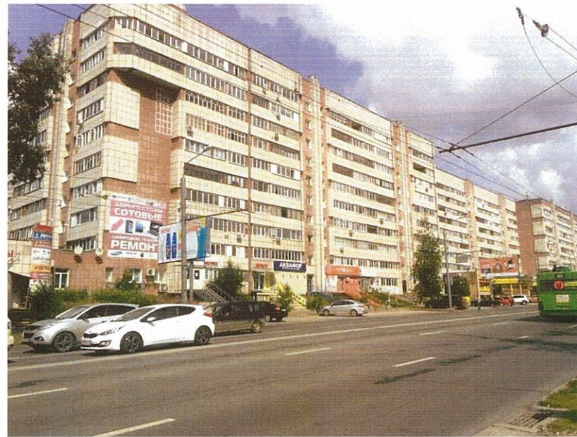
Существующее состояние фасадов (фотофиксация)
