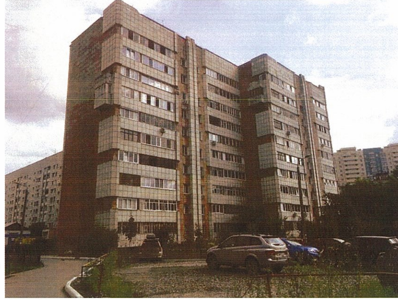
Существующее состояние фасадов (фотофиксация)
