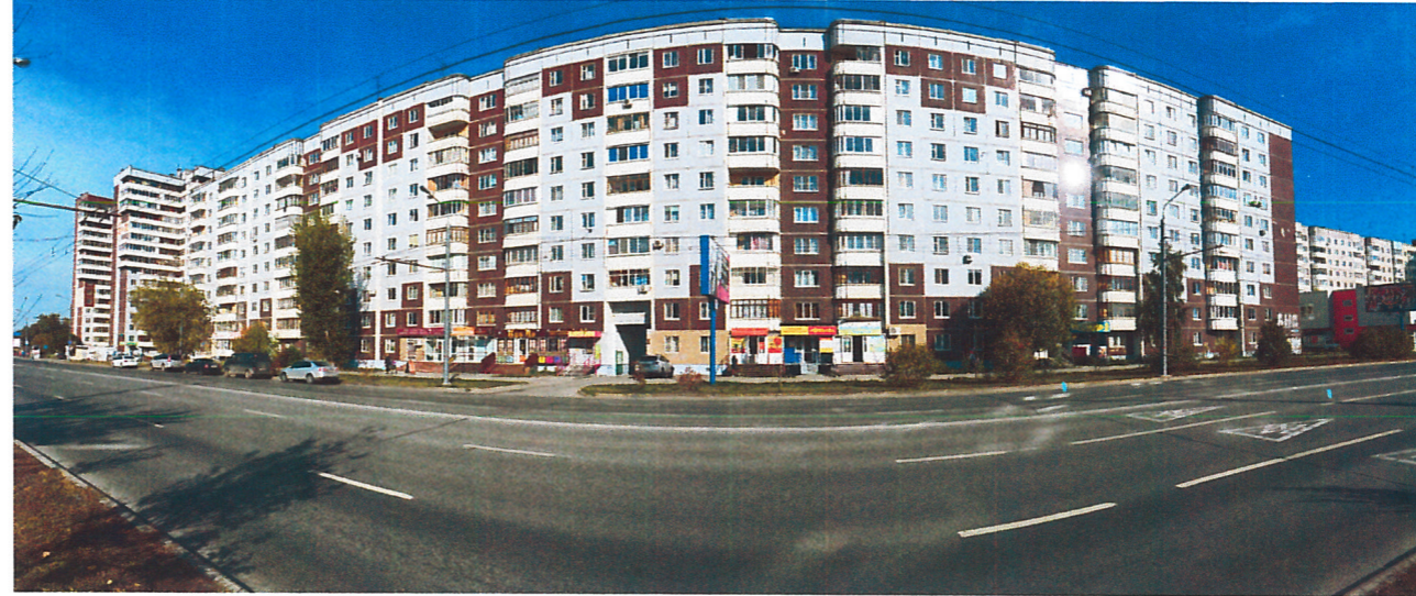
Существующее состояние главного фасада (фотофиксация).
