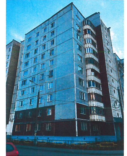
Существующее состояние дворового фасада (фотофиксация).
