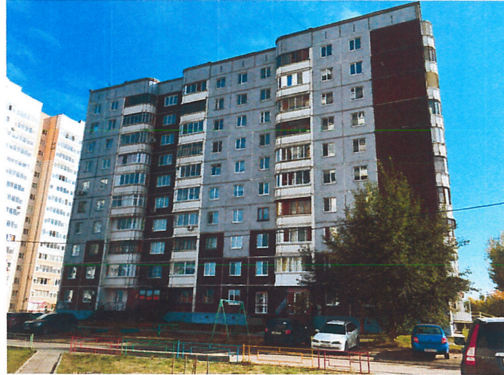
Существующее состояние бокового фасада (фотофиксация).
