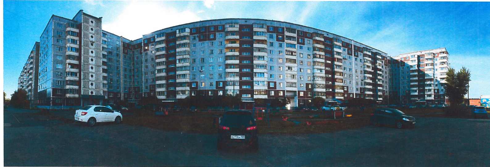
Существующее состояние дворового фасада (фотофиксация).
