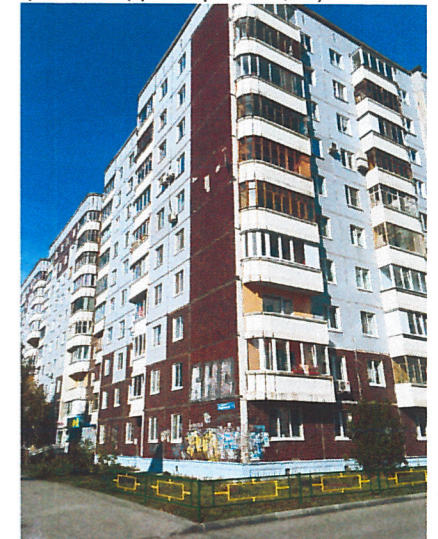
Существующее состояние бокового фасада (фотофиксация).
