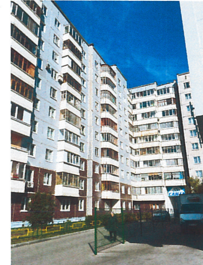
Существующее состояние бокового фасада (фотофиксация).
