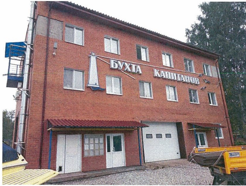
Существующее состояние фасадов (фотофиксация)
