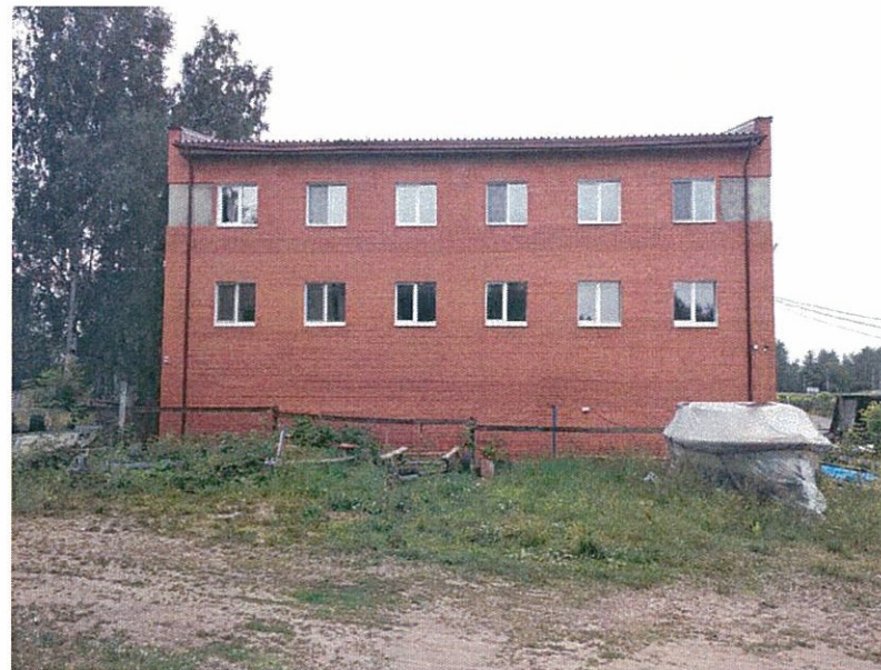
Существующее состояние фасадов (фотофиксация)
