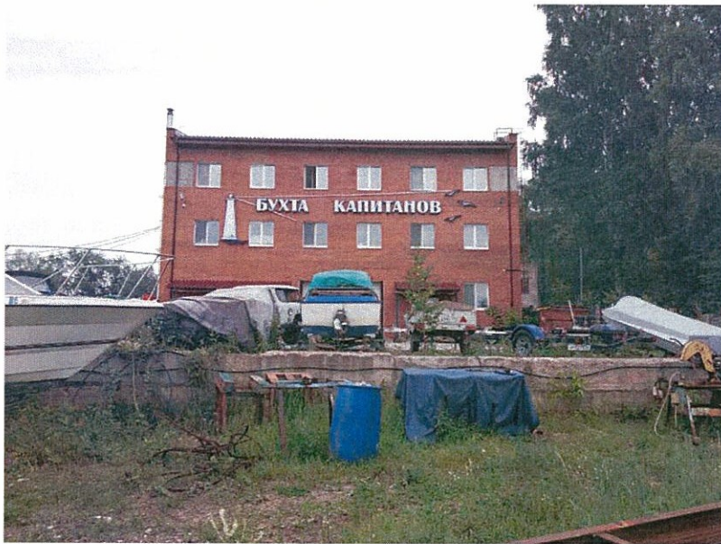
Существующее состояние фасадов (фотофиксация)
