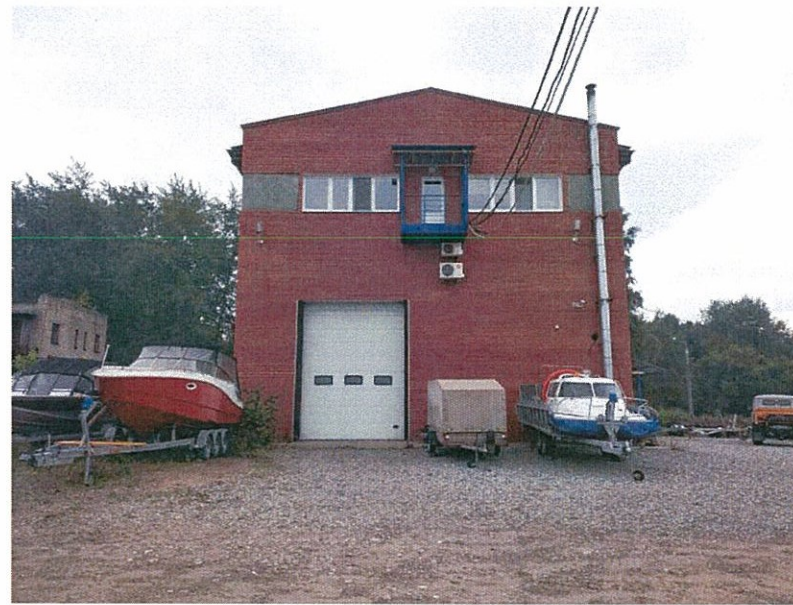
Существующее состояние фасадов (фотофиксация)
