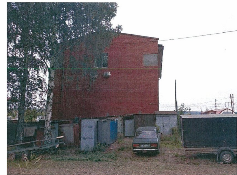
Существующее состояние фасадов (фотофиксация)
