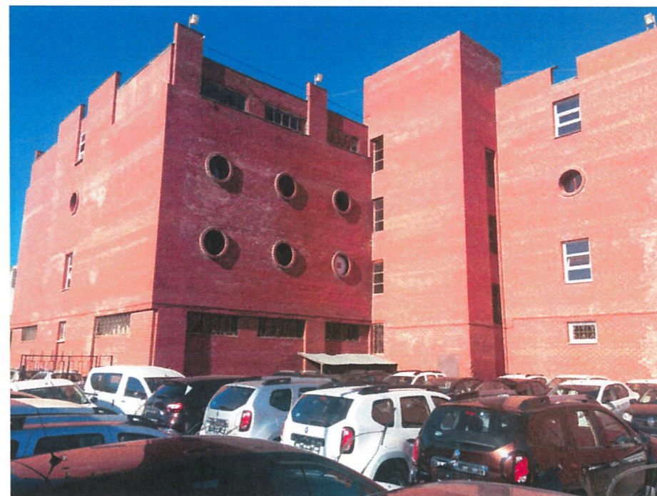
Существующее состояние фасадов (фотофиксация)
