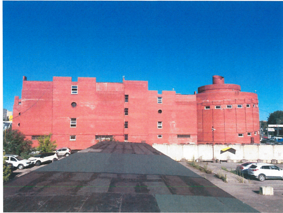
Существующее состояние фасадов (фотофиксация)
