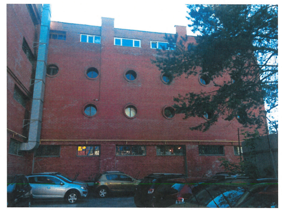
Существующее состояние фасадов (фотофиксация)
