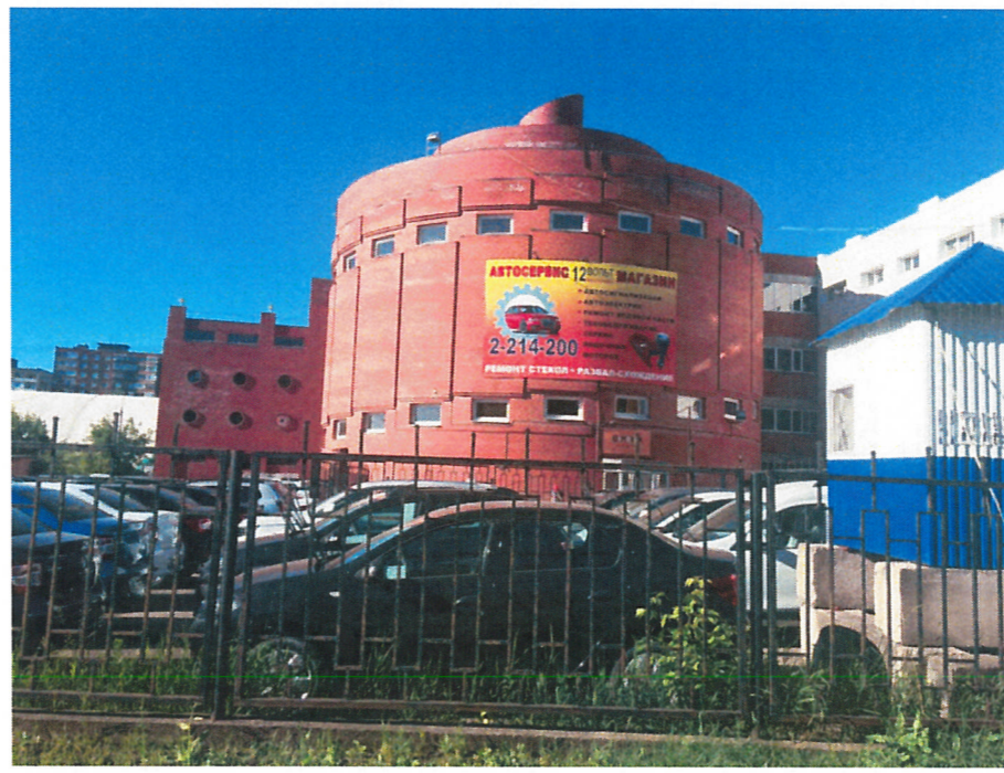
Существующее состояние фасадов (фотофиксация)
