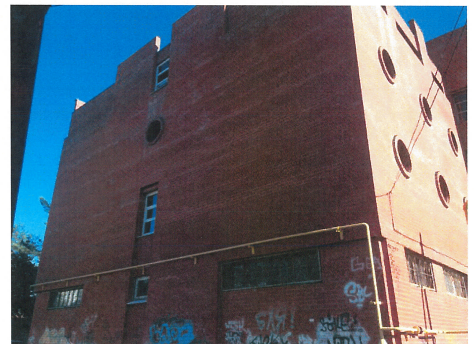
Существующее состояние фасадов (фотофиксация)
