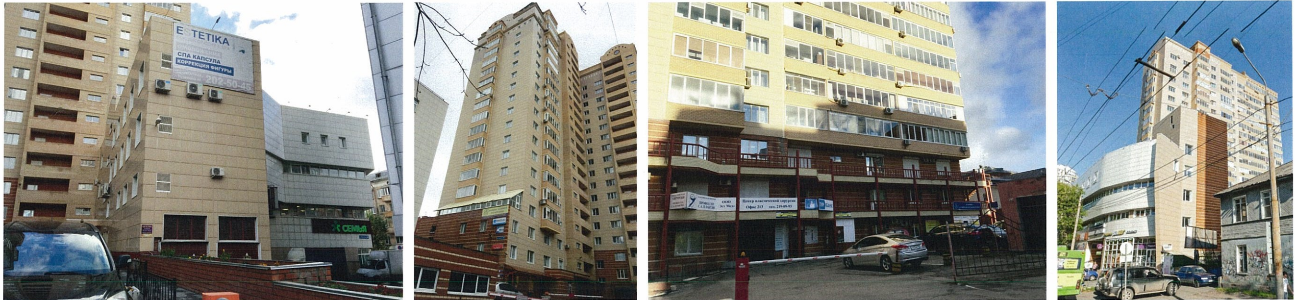
Существующее состояние боковых фасадов (фотофиксация).
