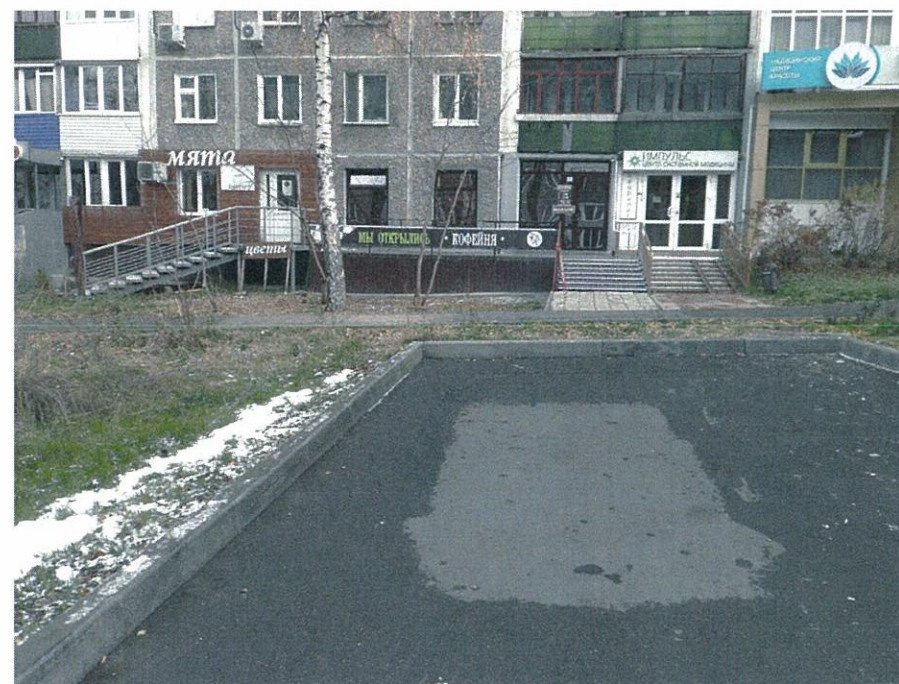
Существующее состояние входной группы нежилого помещения с кадастровым номером 59:01:4410139:93
