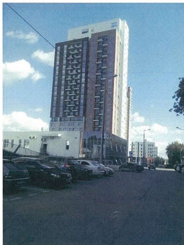
Существующее состояние фасадов (фотофиксация)
