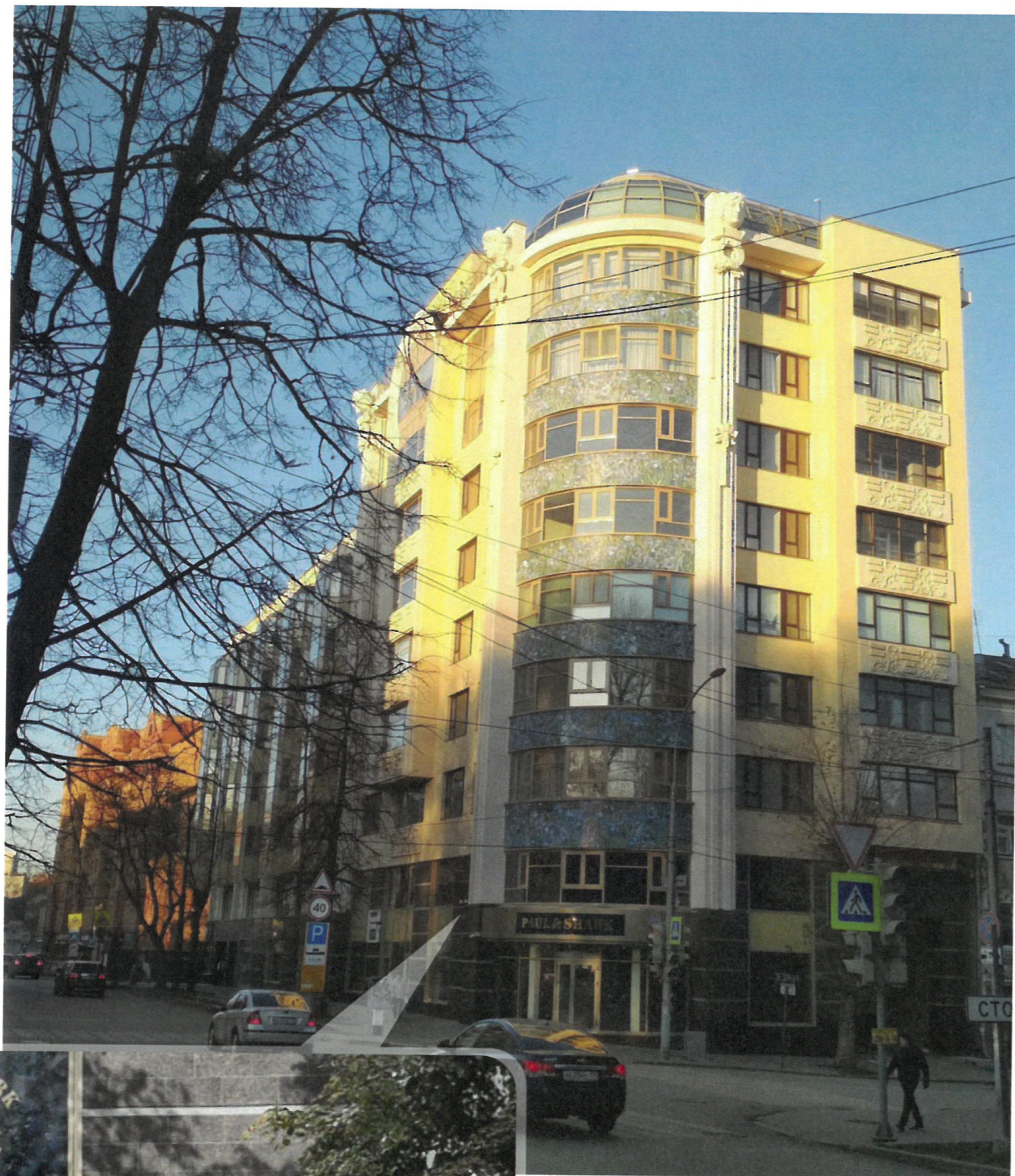
Фасад с улицы Сибирская (существующее положение)
