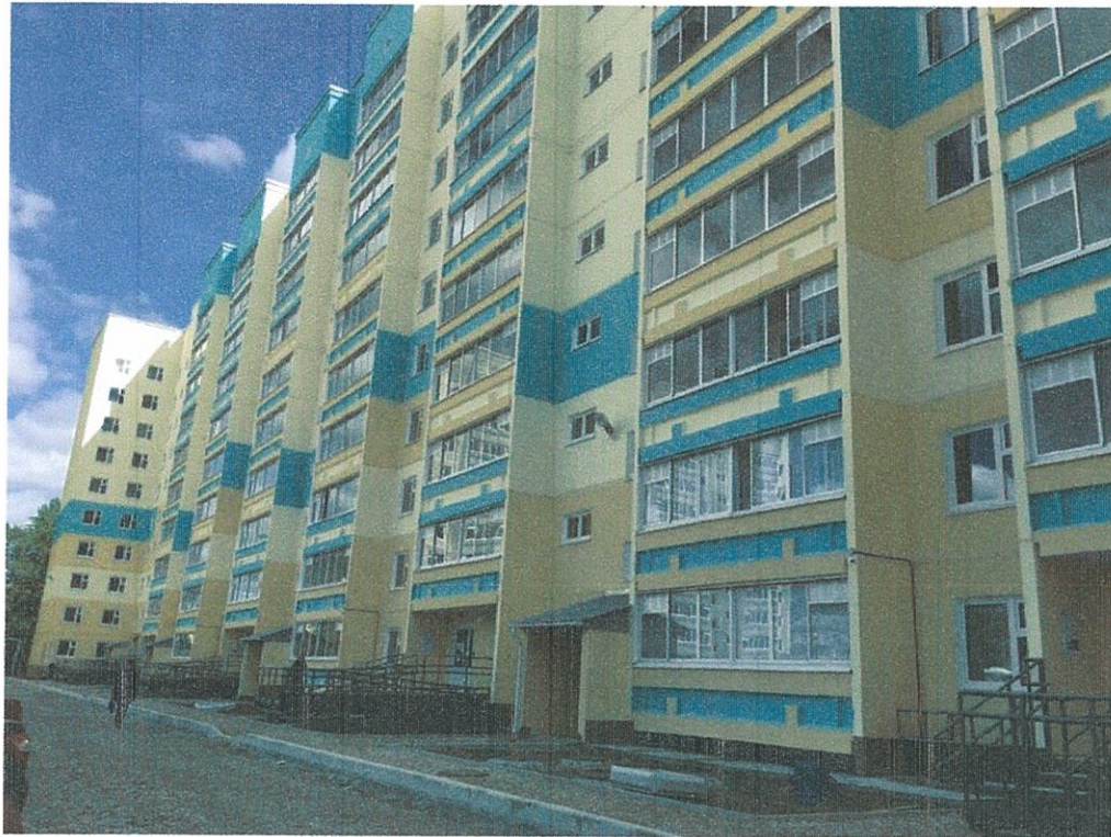
Фасад со стороны ул. Адмирала Ушакова
