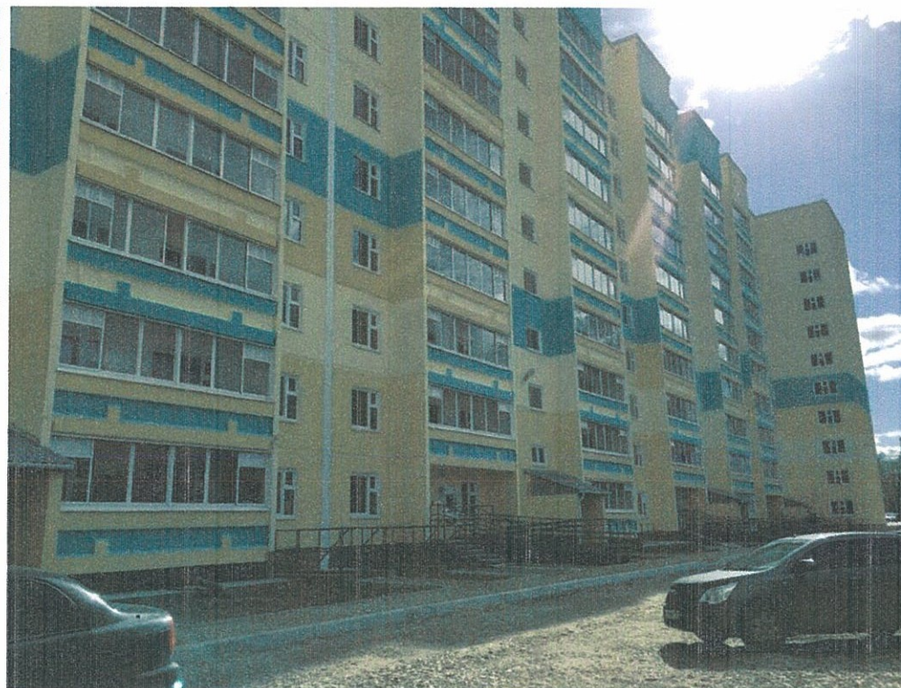
Фасад со стороны ул. Адмирала Ушакова
