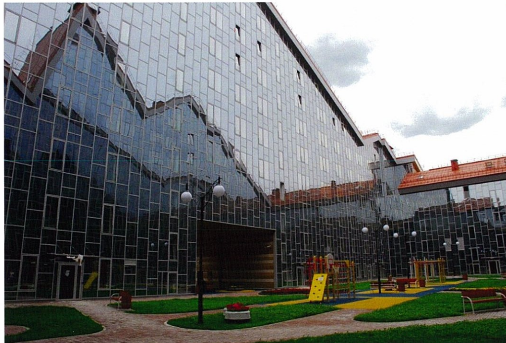
Существующее состояние дворового фасада
