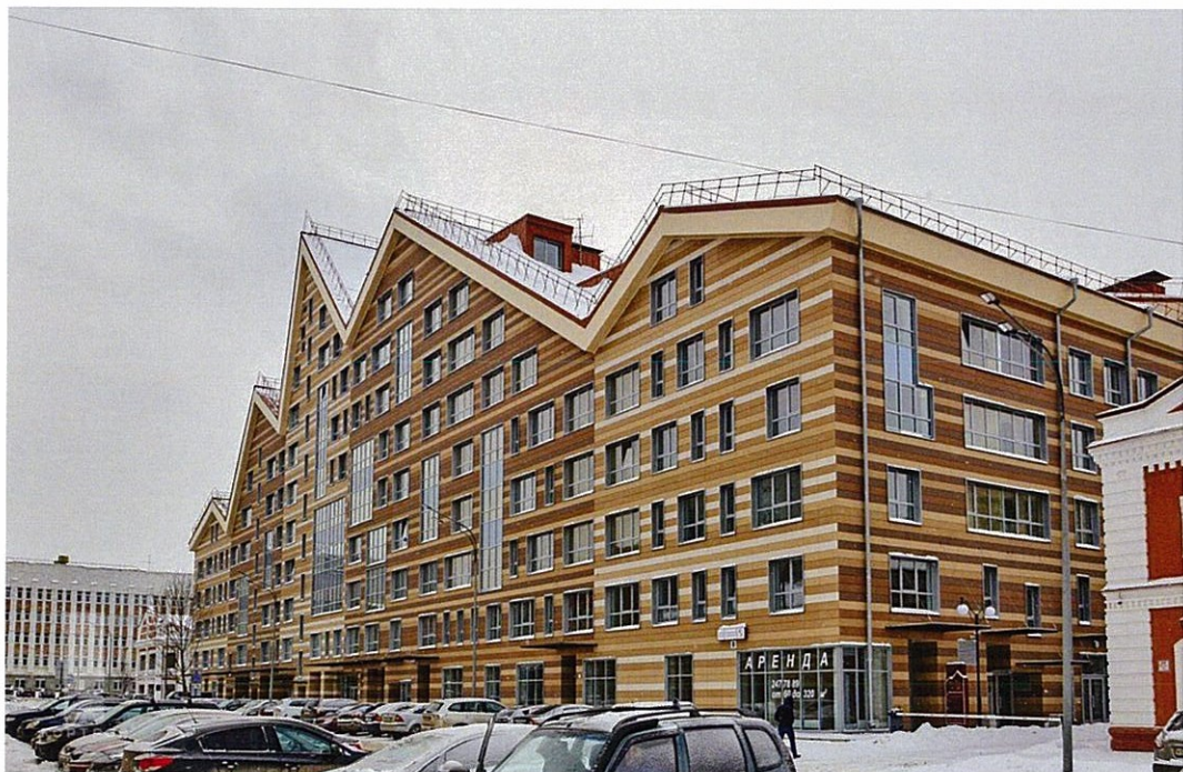
Существующее состояние главного фасада
