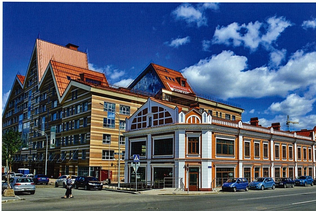
Существующее бокового фасада
