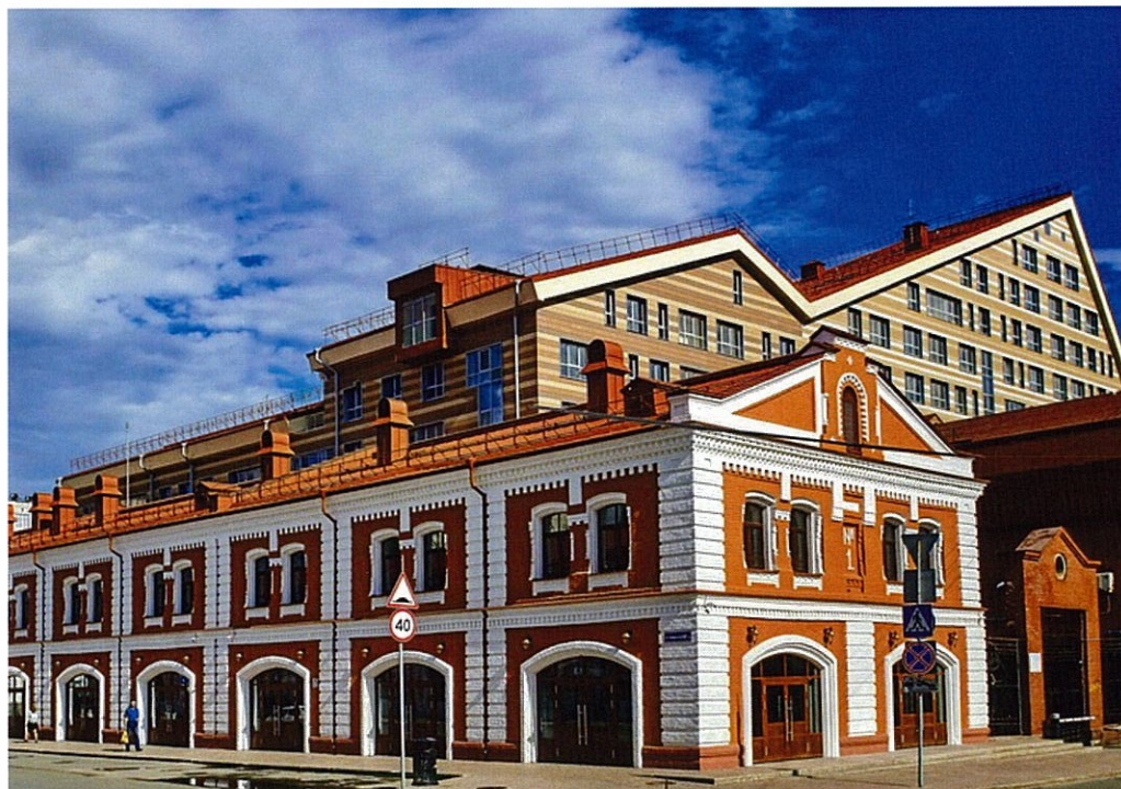
Существующее бокового фасада
