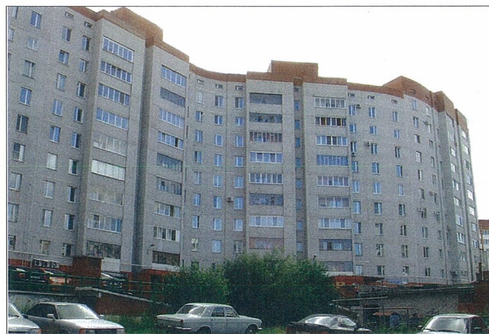
Существующее состояние дворового фасада
