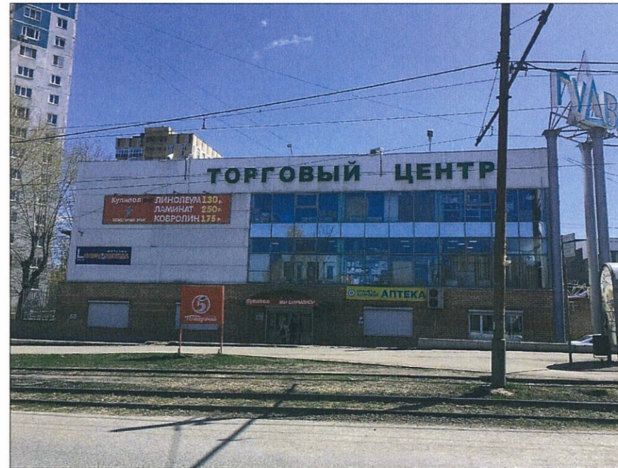
Главный фасад по ул. Уральская
