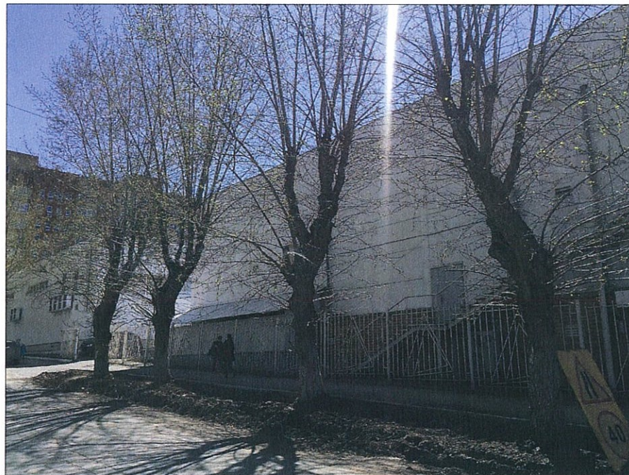
Боковой фасад по ул. Грачева
