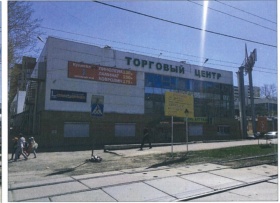
Главный фасад по ул. Уральская
