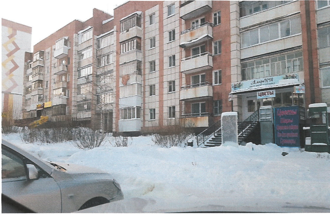
Главный фасад по ул.Вильямса
