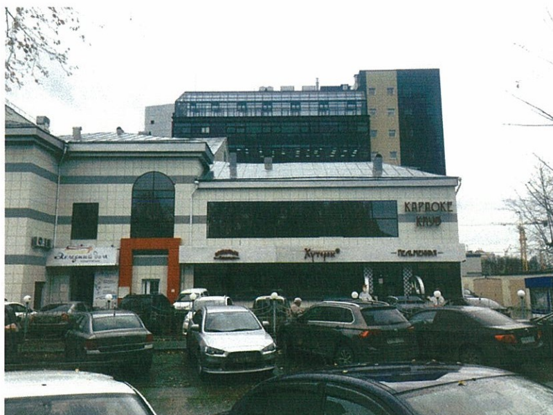
Существующее состояние главного фасада (фотофиксация).
